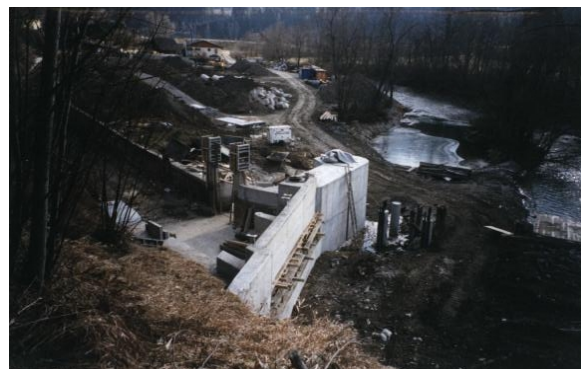
奧地利水電站建設 355
