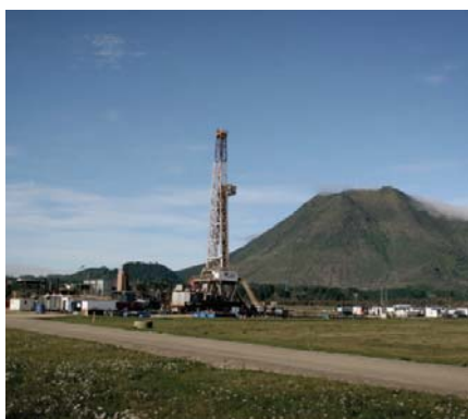
Kawerau 地熱發電站 139
