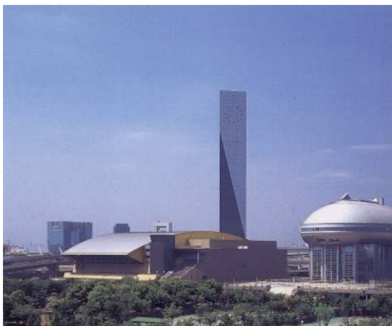
圖 1 建有三角形煙囪的有明海焚化爐廠房
