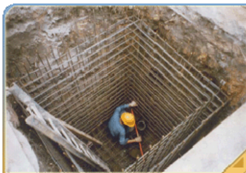
银线湾的污水系统接驳工程
