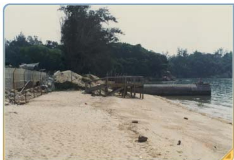
1980 年代典型雨水渠把污水直接排至泳滩
