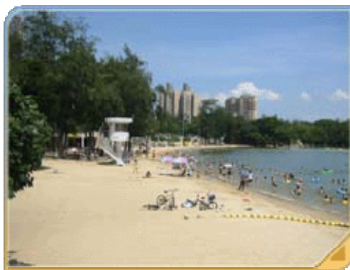
1981 年青山湾面貌，泳滩远处有水渠排出污水(上)， 2005 年重新开放(下)
