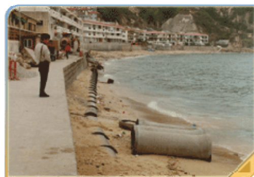
1989 年长洲东湾的排水渠改道工程
