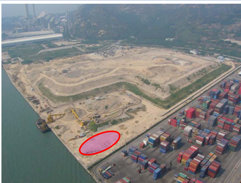
屯門 38 區建築廢物篩選分類設施
