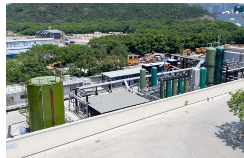
新界东南堆填区的堆填气体回收设施
