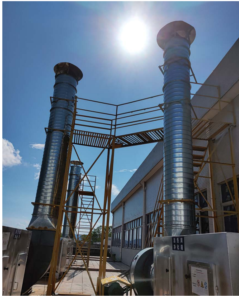
结合紫外线光催化氧化及活性碳的有机废气净化系统以减少挥发性有机化合物排放
