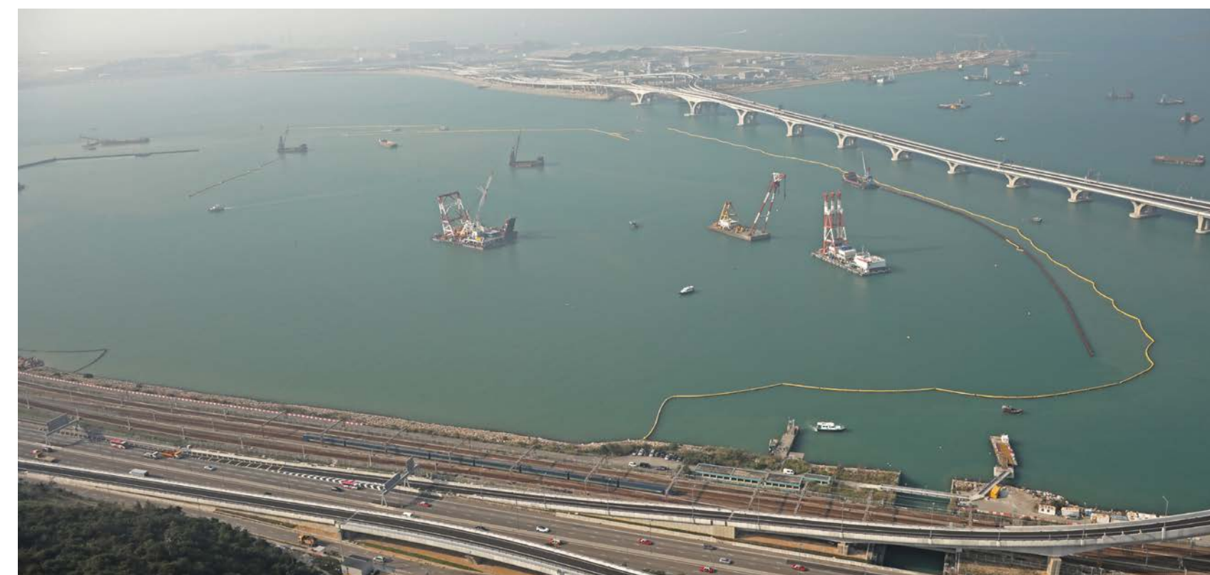
围封填海工程范围的外围隔泥幕
