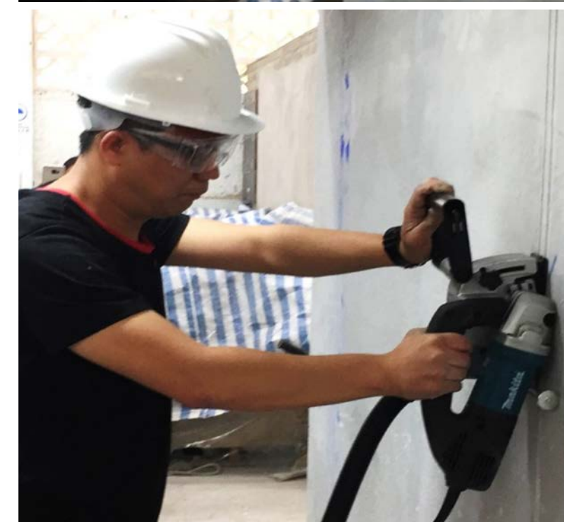
砖墙开槽机(下)比传统手提撞击式破碎机(上)产生较少噪音与尘埃
