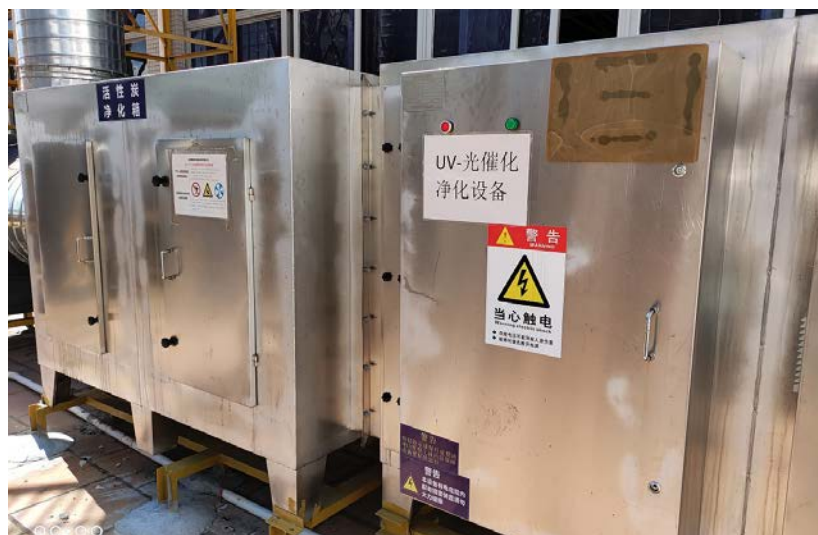
结合紫外线光催化氧化及活性碳的有机废气净化系统以减少挥发性有机化合物排放
