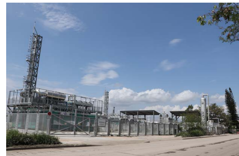
新界西堆填区的堆填气体发电设施
