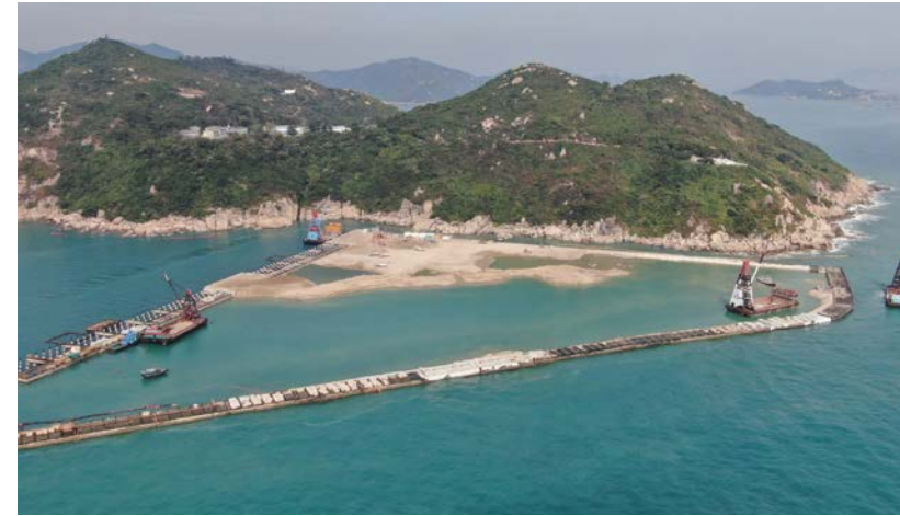
| I-PARK 人工島填海工程正在進行中 (2020 年 12 月)
