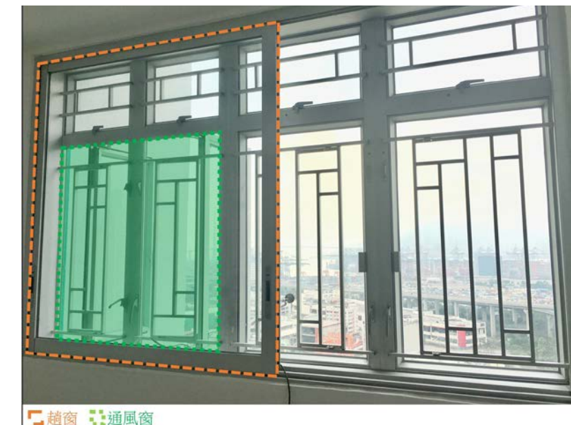
海盈邨已安裝擋音式減音窗，可緩解由西九龍公路所產生的交通噪音
