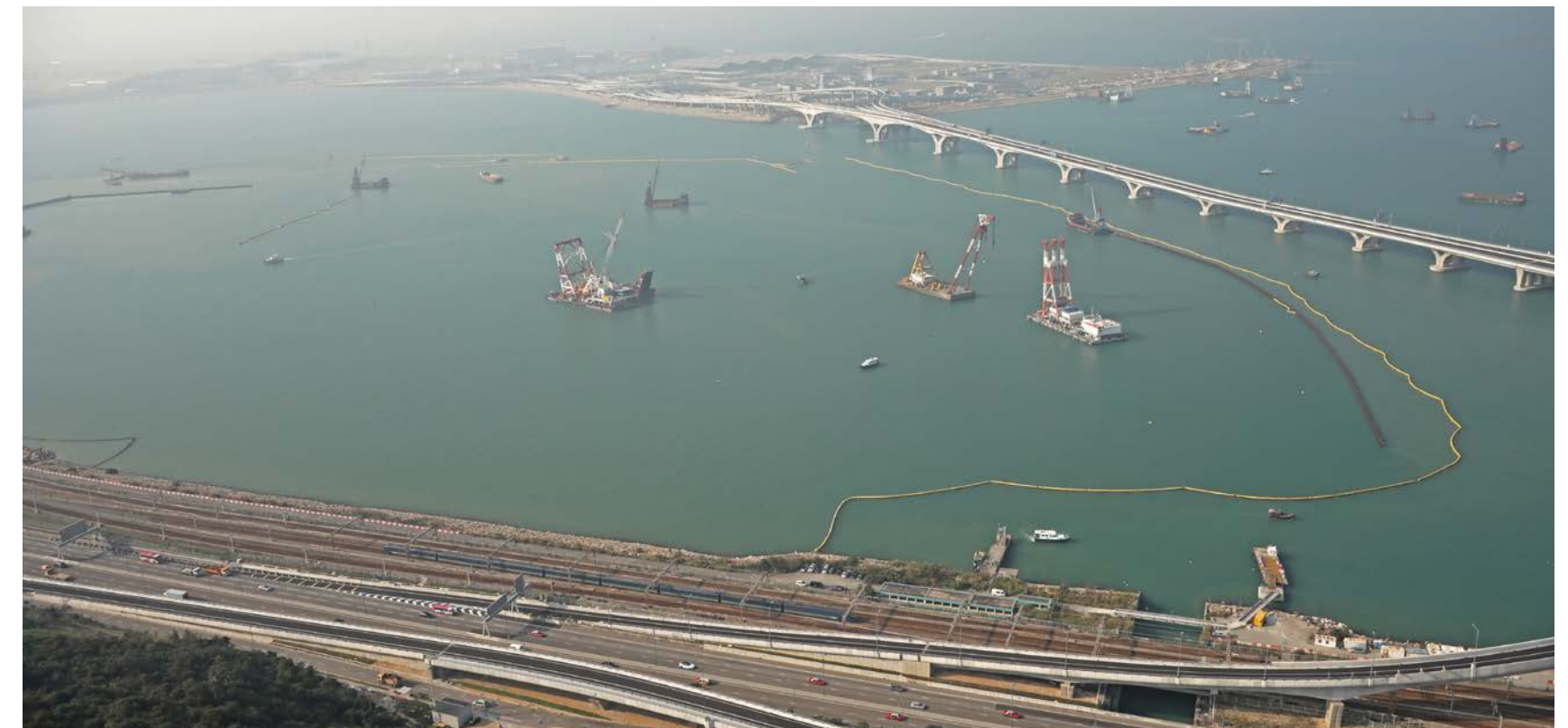
圍封填海工程範圍的外圍隔泥幕
