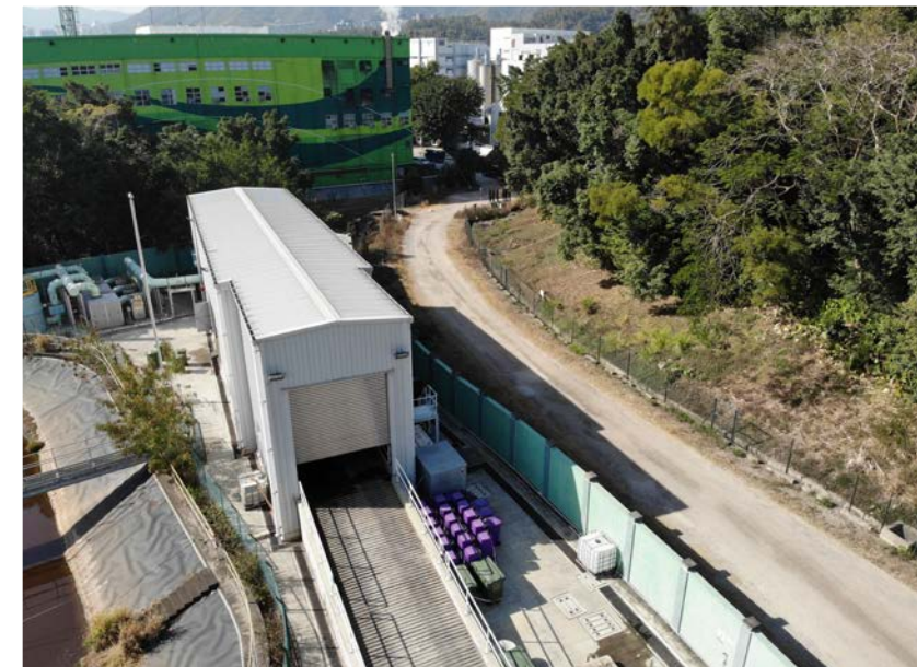
| 「廚餘、污泥共厭氧消化」試驗計劃下的大埔污水處理廠廚餘預處理設施
