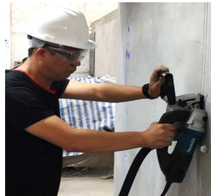
磚牆開槽機(下)比傳統手提撞擊式破碎機(上)產生較少噪音與塵埃
