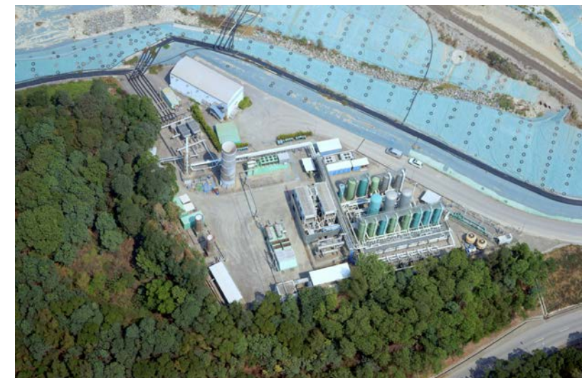
新界東北堆填區的堆填氣體處理設施
