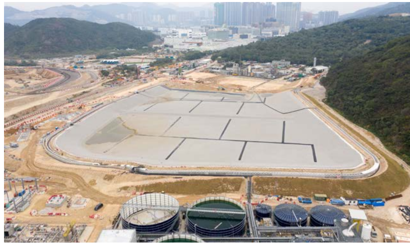
新界東南堆填區的擴建工程在進行中
