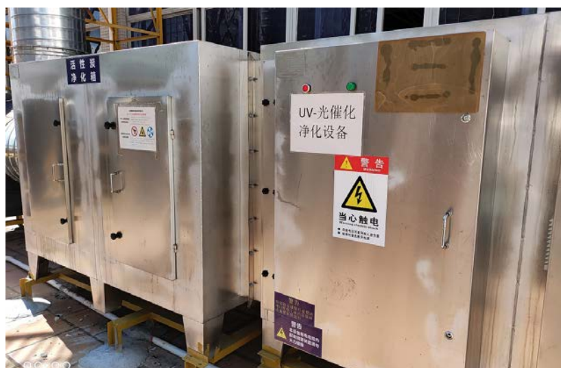
結合紫外線光催化氧化及活性碳的有機廢氣淨化系統以減少揮發性有機化合物排放
