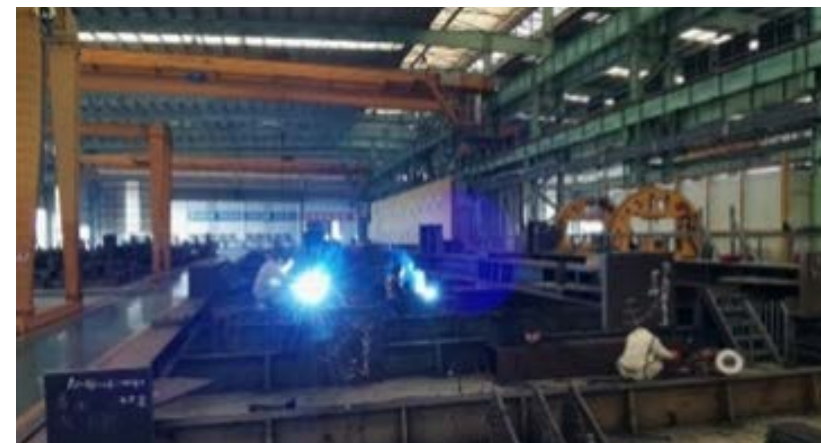
| 為珠海預製工地之機電組件鋼構件進行裝配及焊接 (2020 年 12 月)
