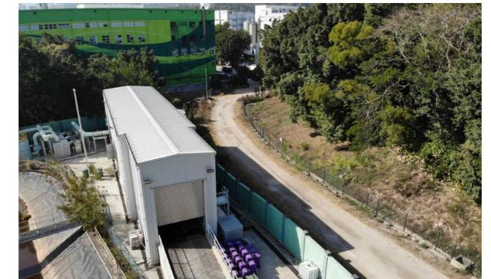
用於「廚餘、污泥共厭氧消化」試驗計劃的大埔污水處理廠廚餘預處理設施
