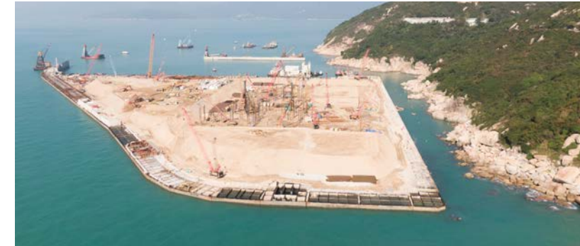
| I-PARK1 人工岛的工地开拓和打桩工程正在进行中 (2021 年 12 月)
