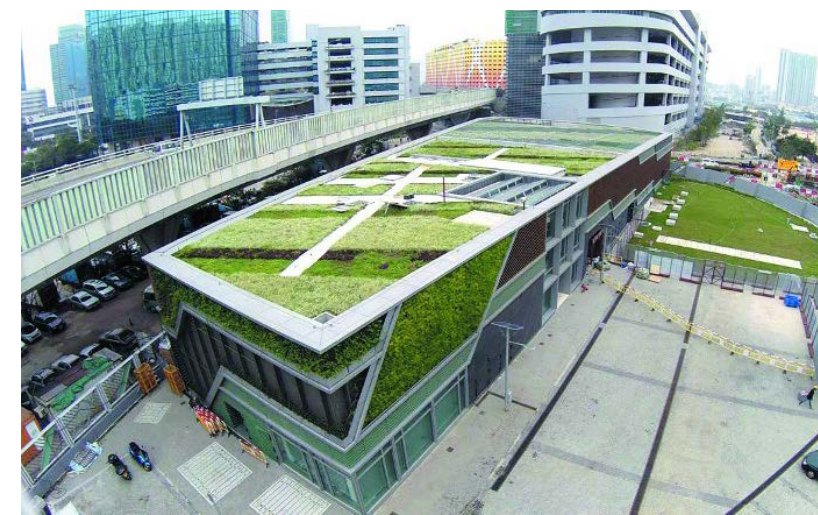
| 节能绿建-启德发展区区域供冷系统
