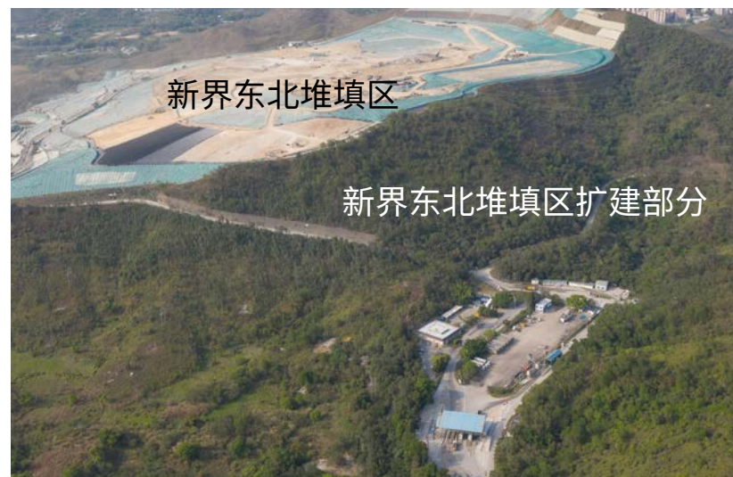
新界东北堆填区及其扩建部分
