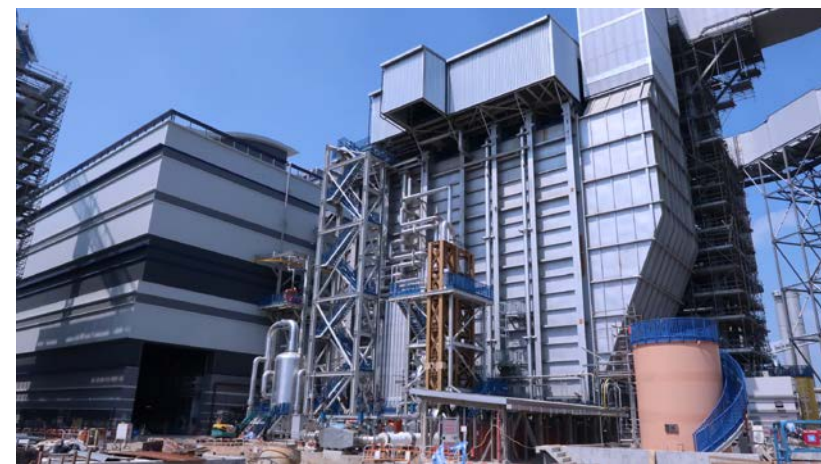
香港电灯有限公司（港灯）位于南丫发电厂的新燃气机组
