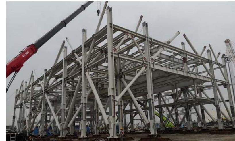
| 在珠海的 I-PARK1 预制场预制机电组件的钢结构安装 (2021 年 12 月)
