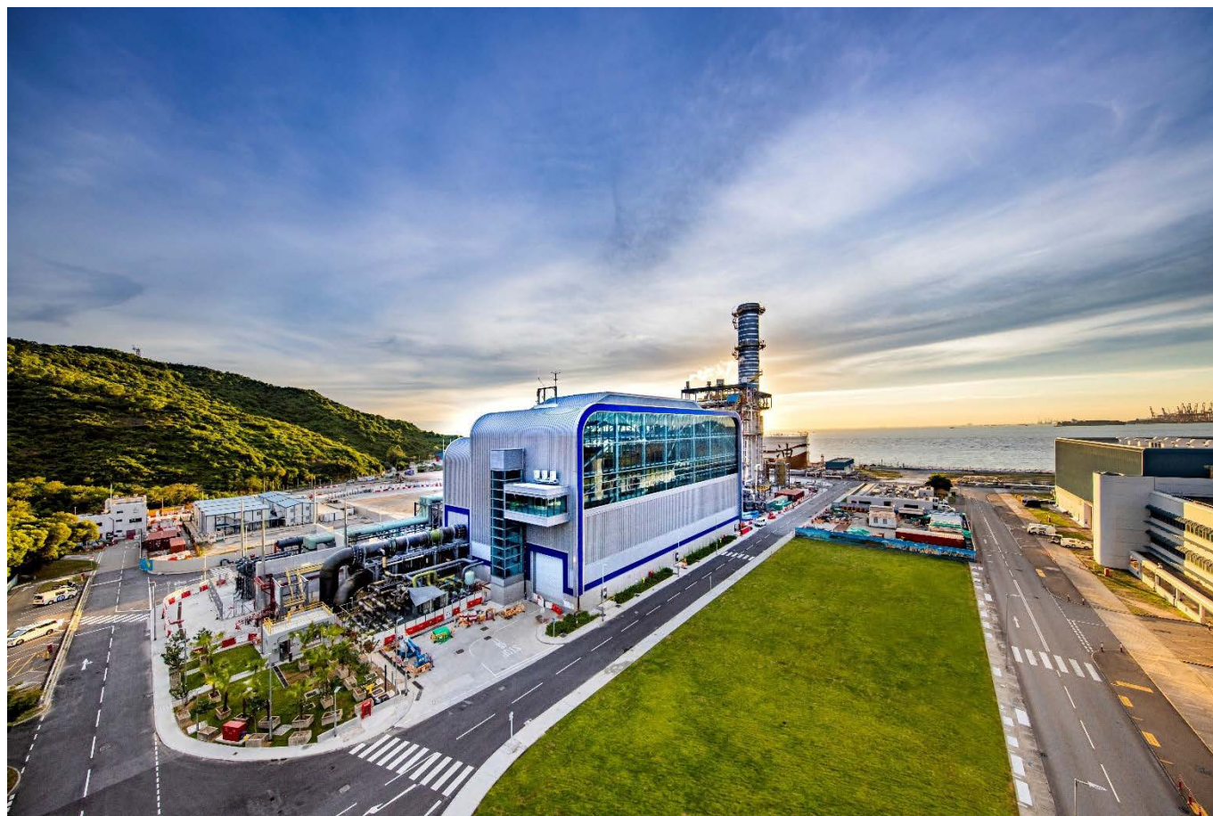
位于龙鼓滩发电厂的新燃气发电机组
