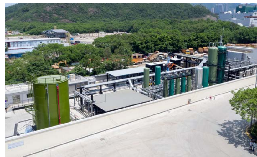
新界东南堆填区-堆填气体发电设施
