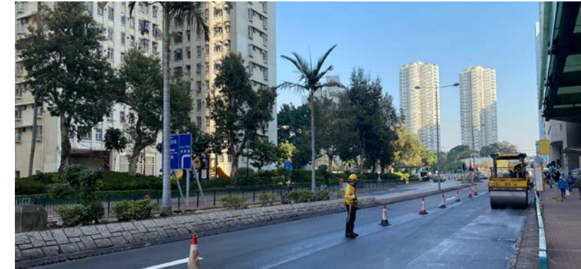
屯门湖翠路的路面铺设工程
