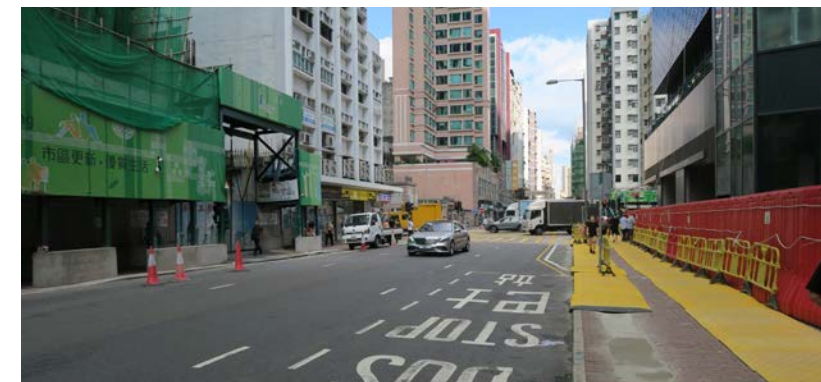
在地区路段中使用 PMSMA6 — 深水埗元州街（由东京街至永隆街）
