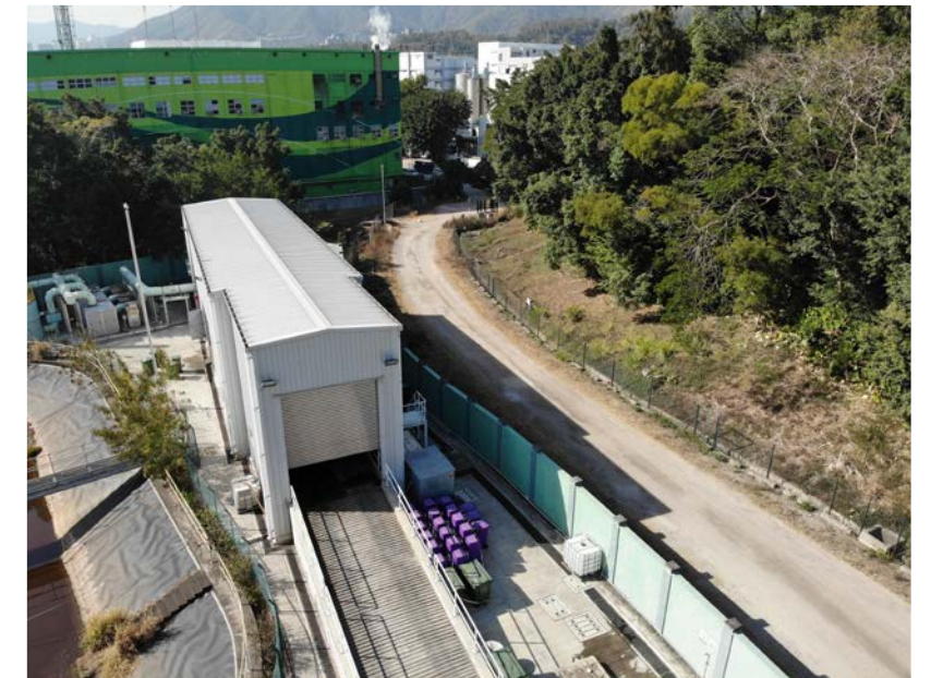
| 用于「厨余、污泥共厌氧消化」试验计划的大埔污水处理厂厨余预处理设施
