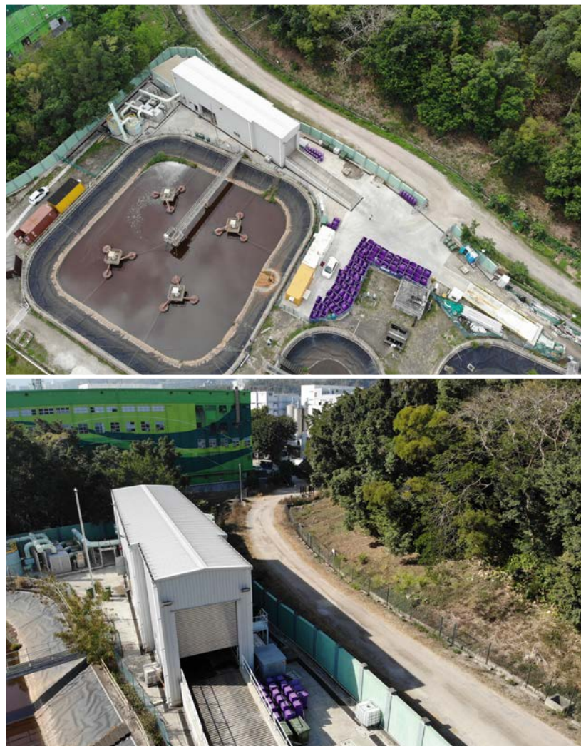
用于「厨余、污泥共厌氧消化」试验计划的大埔污水处理厂厨余预处理设施
