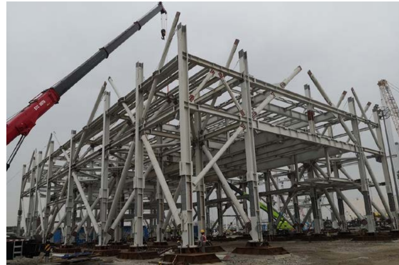
在珠海的 I-PARK1 预制场预制机电组件单元的钢结构安装 (2021 年 12 月)
