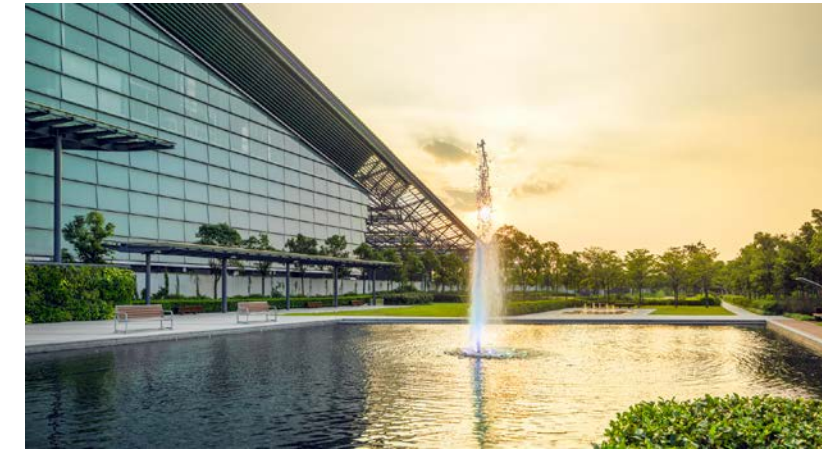
T-PARK [源·区] 结合多项先进科技，包括污泥焚化、发电、海水化淡和污水处理，还设有社区康乐设施和教育中心。
