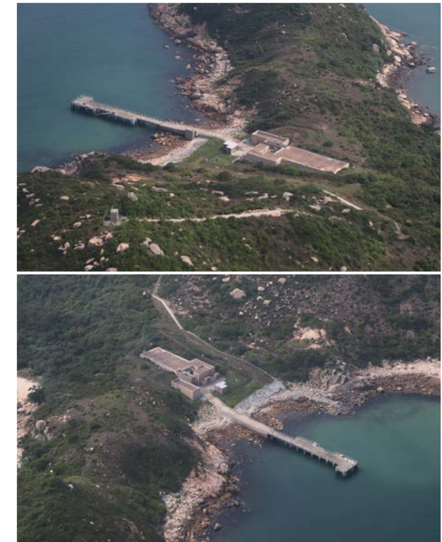
小鸦洲低放射性废物贮存设施鸟瞰照片
