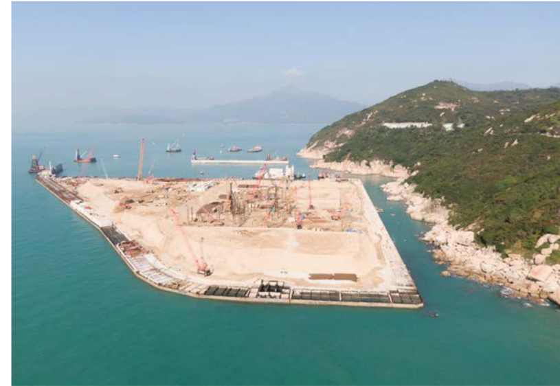
I-PARK1 人工岛的工地开拓和打桩工程正在进行中 (2021 年 12 月)
