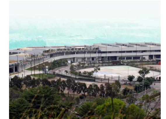
废电器电子产品 处理及回收设施
