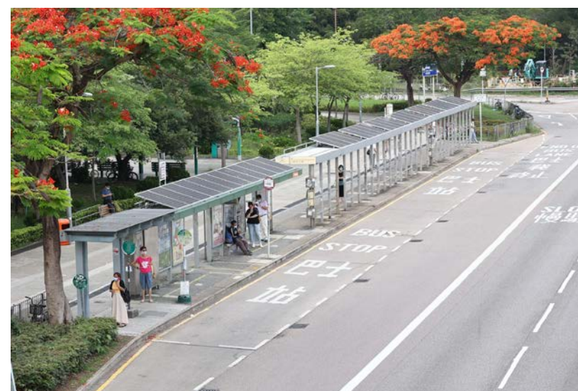
「上網電價」計劃鼓勵私營界別發展可再生能源。九龍巴士（一九三三）有限公司及龍運巴士有限公司已在巴士站上蓋裝設太陽能裝置，為巴士站提供照明。
