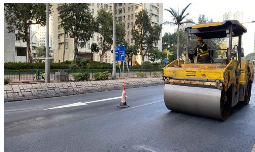
在屯門湖翠路碾平剛鋪上 PMSMA6 的路面
