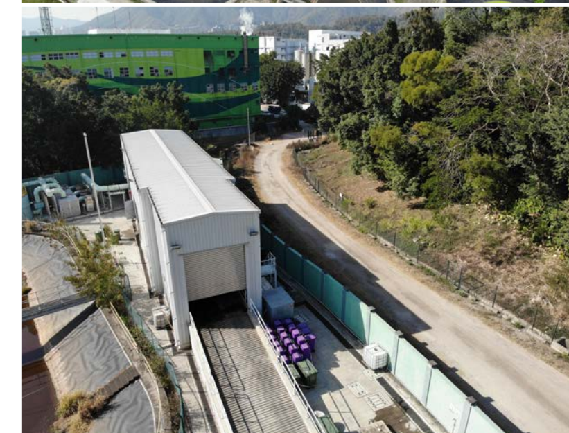
| 用於「廚餘、污泥共厭氧消化」試驗計劃的大埔污水處理廠廚餘預處理設施
