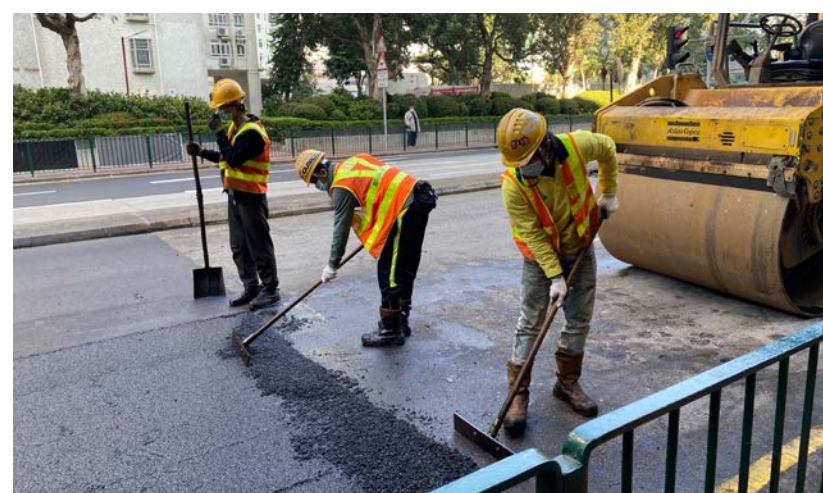
在屯門湖翠路鋪設 PMSMA6 路面
