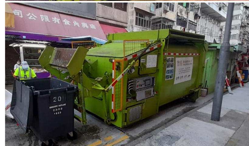
壓縮機收集「三無大廈」居民棄置的廢物
