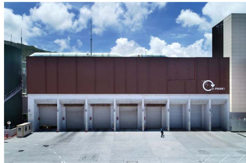
| O-PARK1 正面照片
