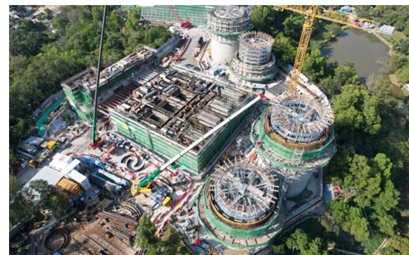
| O-PARK2 工程正在進行中（2021 年 12 月）
