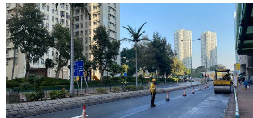
屯門湖翠路的路面鋪設工程
