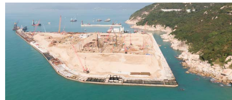
| I-PARK1 人工島的工地開拓和打樁工程正在進行中 (2021 年 12 月)
