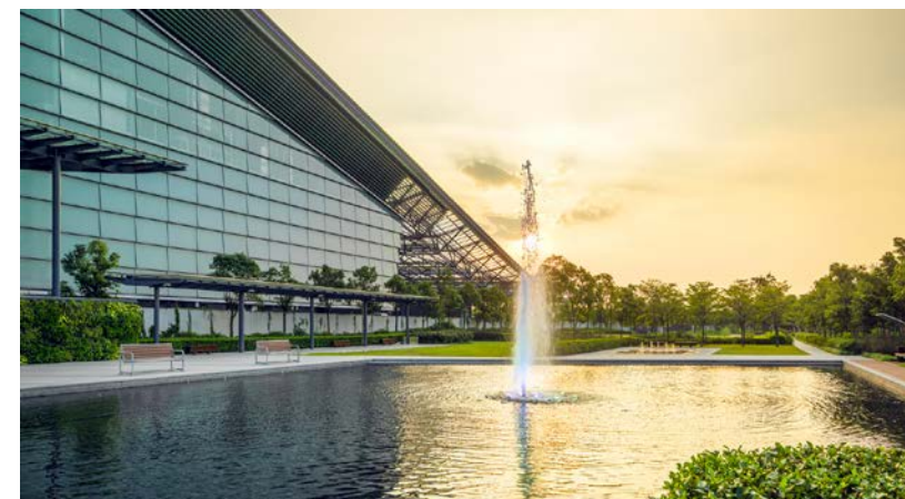
T-PARK [源·區] 結合多項先進科技，包括污泥焚化、發電、海水化淡和污水處理，還設有社區康樂設施和教育中心。
