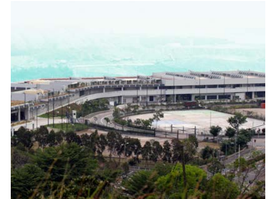
廢電器電子產品 處理及回收設施
