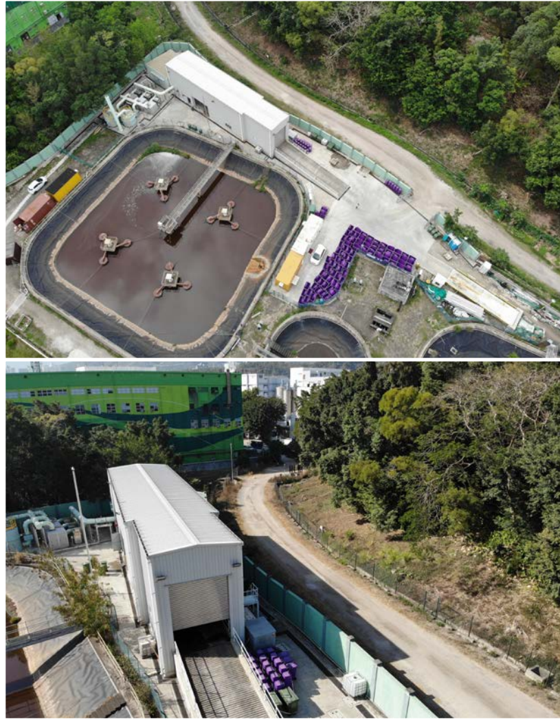
用於「廚餘、污泥共厭氧消化」試驗計劃的大埔污水處理廠廚餘預處理設施
