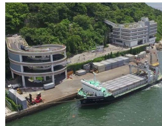
港島西廢物轉運站
