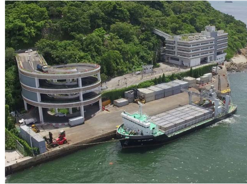
港島西廢物轉運站
