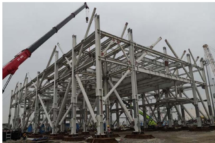
在珠海的 I-PARK1 預製場預製機電組件單元的鋼結構安裝 (2021 年 12 月)
