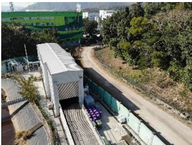
在「厨余、污泥共厌氧消化」试验计划下于大埔污水处理厂设立的厨余预处理设施
