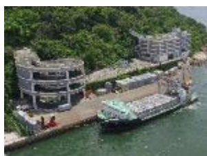
港岛西废物转运站
