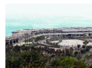
废电器电子产品 处理及回收设施
