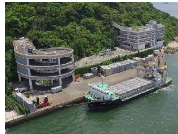
港岛西废物转运站
