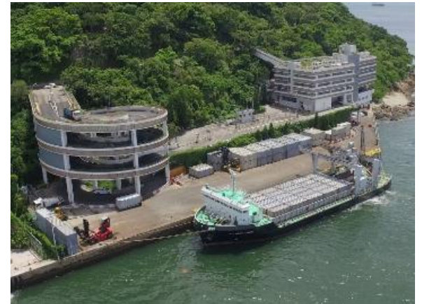
港島西廢物轉運站
