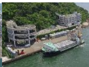
港島西廢物轉運站
