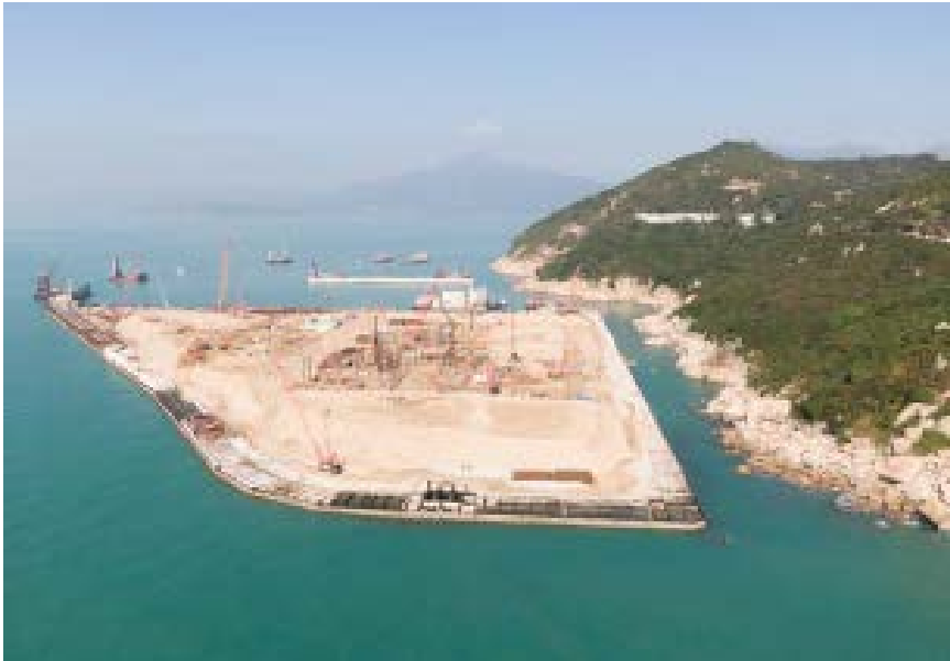
I-PARK1 在人工島的工地正就廠房進行地基和鋼結構架設工程(2022 年)
