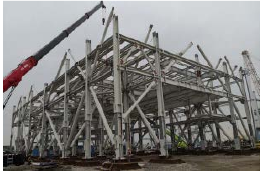
大型機電組件正於珠海預製(2022 年)
