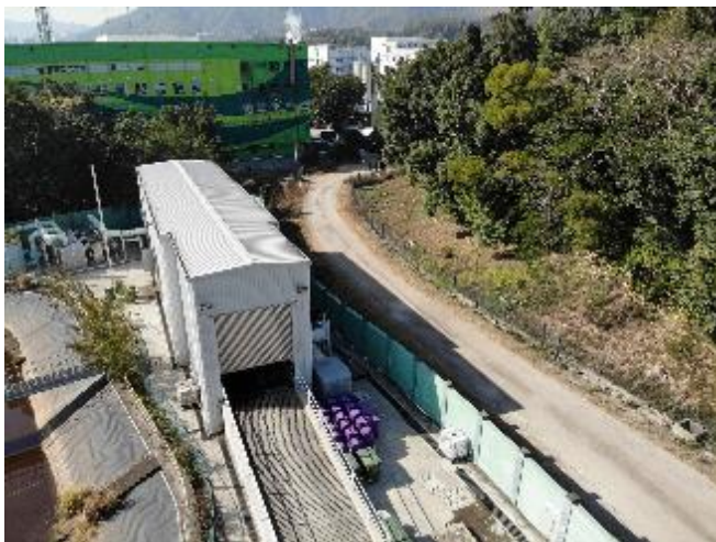
在「廚餘、污泥共厭氧消化」試驗計劃下於大埔污水處理廠設立的廚餘預處理設施
