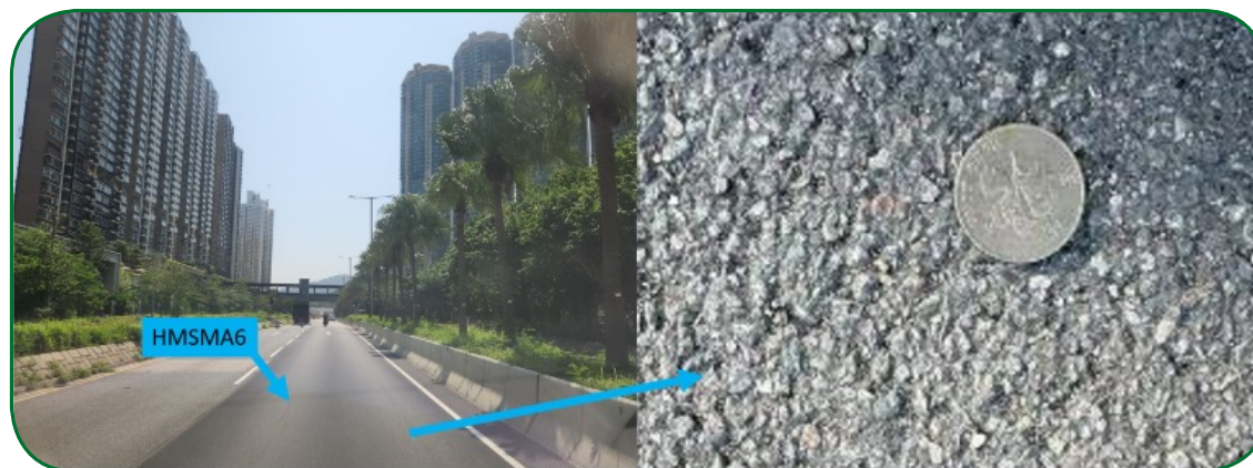
使用 HMSMA6 铺设的地区路段—东涌迎禧路
