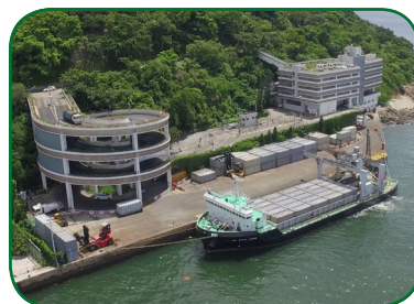
港島西廢物轉運站
