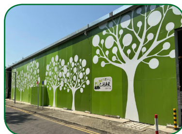
環保園生物炭生產試驗設施
