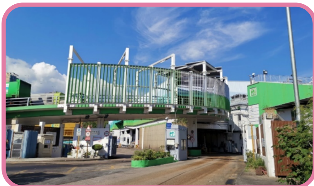
西九龙废物转运站具特色的斜道顶盖
