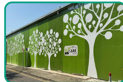
环保园生物炭生产试验设施
