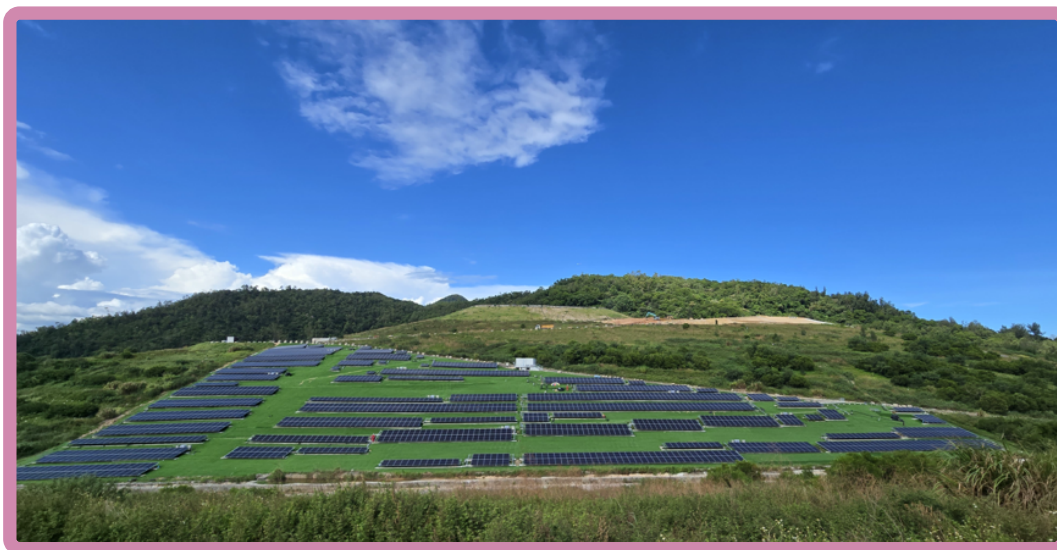
新界东南堆填区可产电 1 兆瓦的太阳能发电场试验计划
