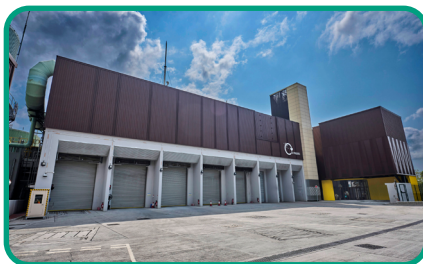
有机资源回收中心 第一期 O·PARK1
