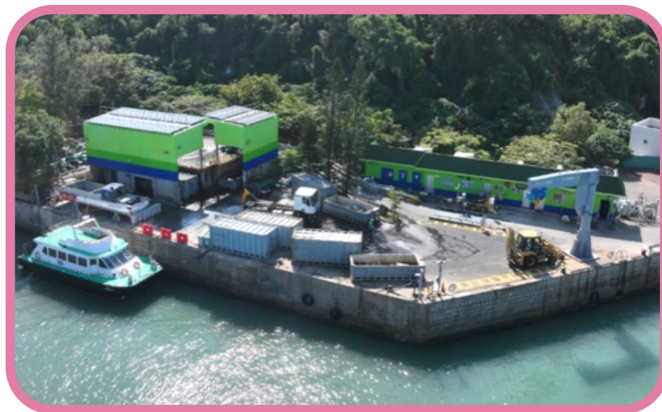
离岛废物转运设施—榕树湾已完成翻新及提升工程，建筑物顶部安装了太阳能板，提供可再生能源供站内设施使用。
