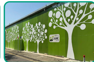
環保園生物炭生產試驗設施
