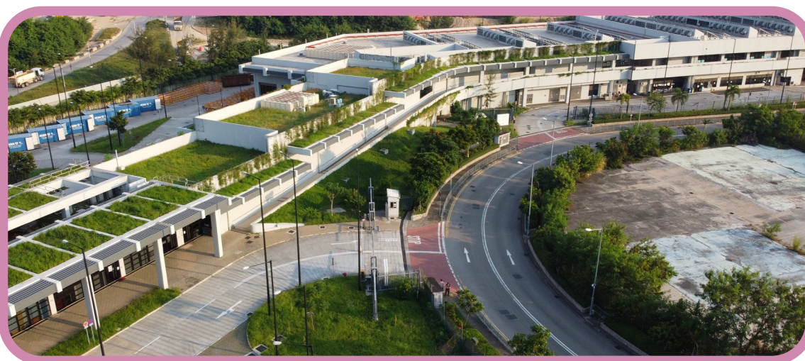
廢電器電子產品處理及回收設施
