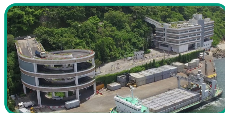
港島西廢物轉運站
