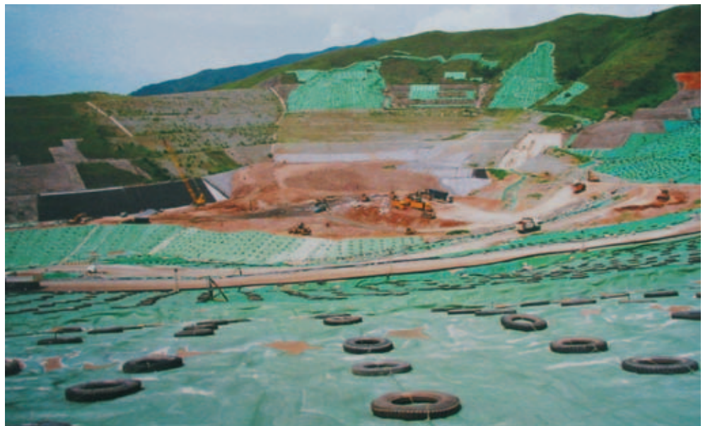
现代化堆填区有防渗漏层防止渗滤污水溢出以免污染地下水
