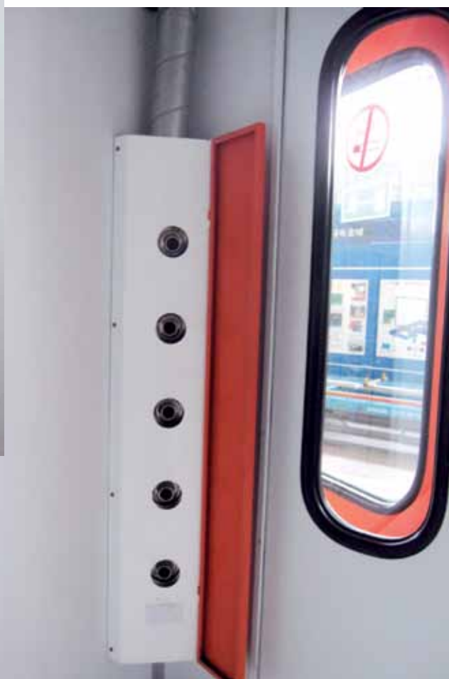
可在噴漆房的牆上四角安裝吹風嘴系統（一排排的吹風嘴） （建議設置，非必要性），縮短水溶性漆料的乾燥時間
