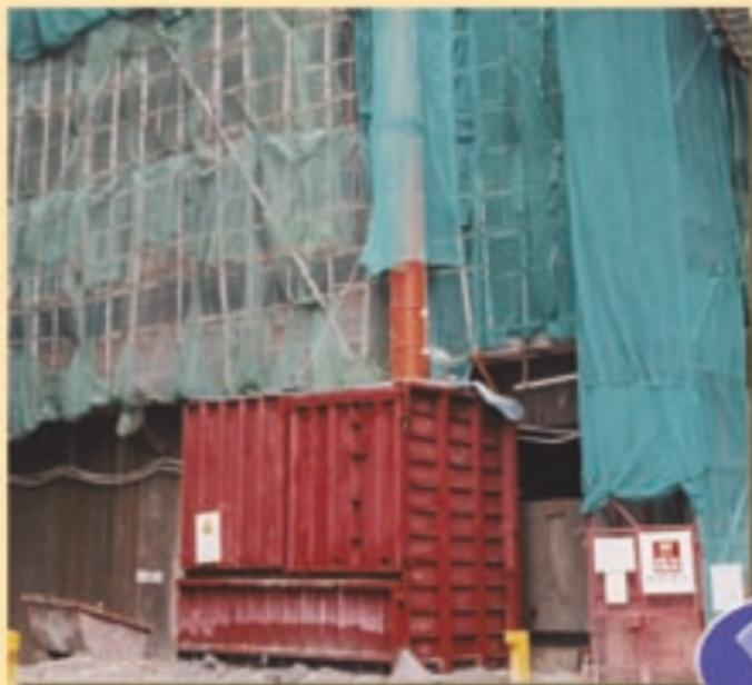
架建隔塵網及設置不矮於 2.4 米高的圍板
