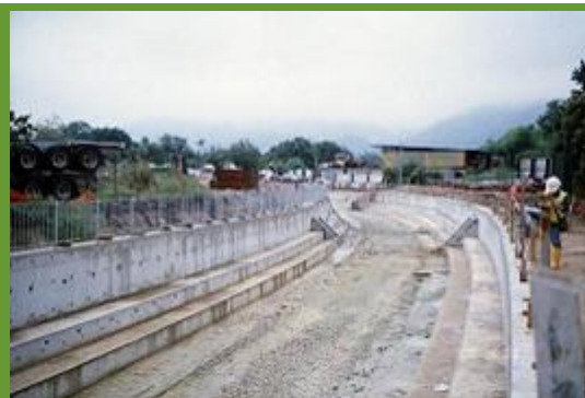
Tidy Construction Site
