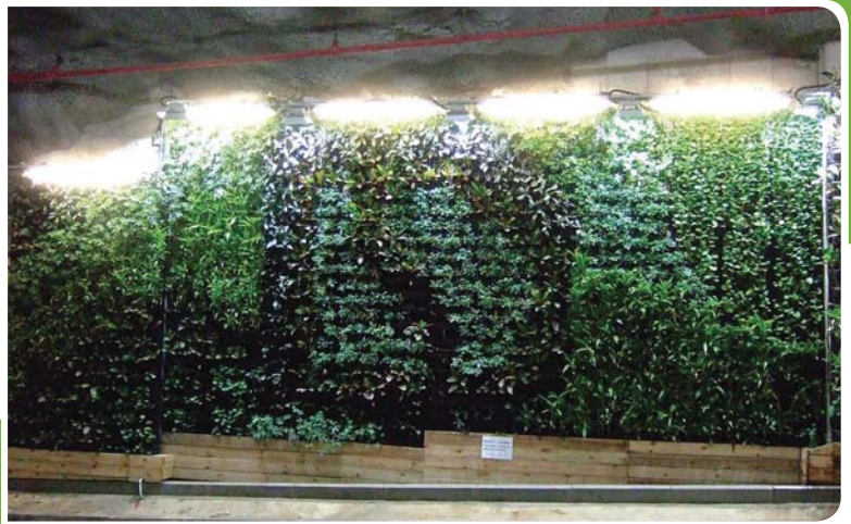
岩洞牆壁上的垂直綠化系統 Cavern wall with VG
