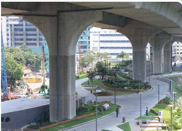
位於青沙公路高架天橋下的蝴蝶谷道寵物公園 Butterfly Valley Road Pet Garden under the viaduct of Tsing Sha Highway
