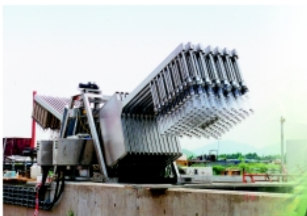
在水底操作中的紫外光燈 Submerged UV lamps in operation
