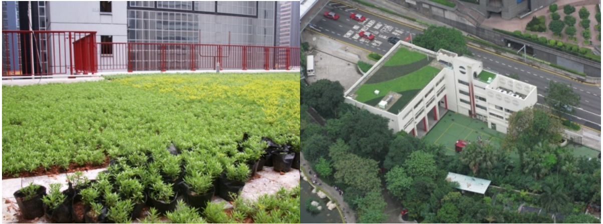
港灣消防局(圖左)、中區消防局(圖右)屋頂的綠化天台
