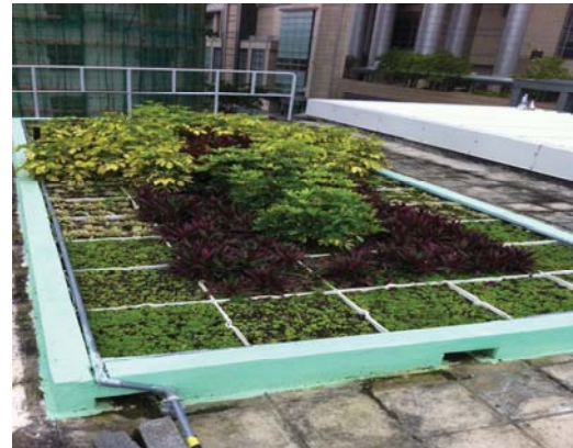
荔枝角消防局的天台綠化工程
