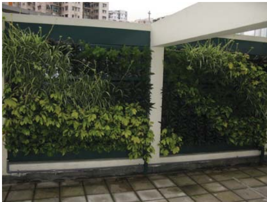
觀塘消防局的天台綠化工程
