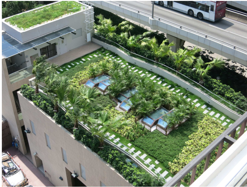
啟德消防局的天台綠化工程 Green Roof at Kai Tak Fire Station
