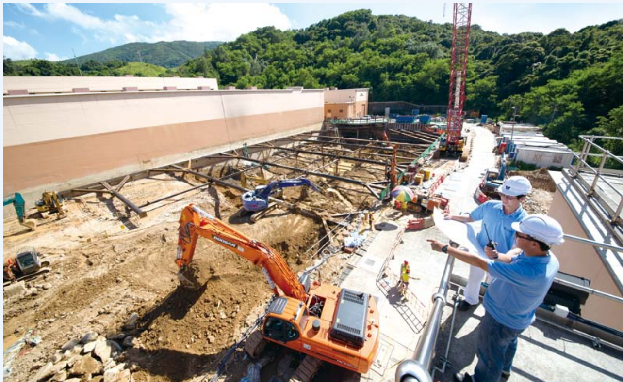
大埔濾水廠擴建工程
