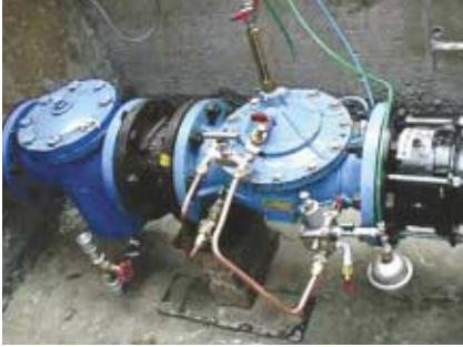
為供水網絡進行水壓管理的先進流量調節式減壓閥。
