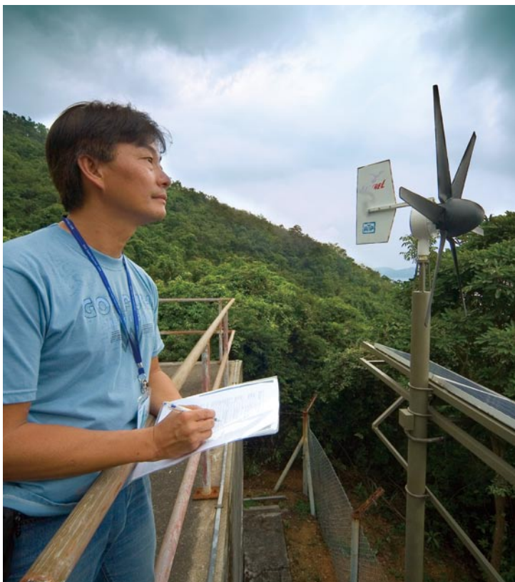
一個推動採用可再生能源的例子——在大美督食水缸裝置風力發電機及太陽能接收板。
