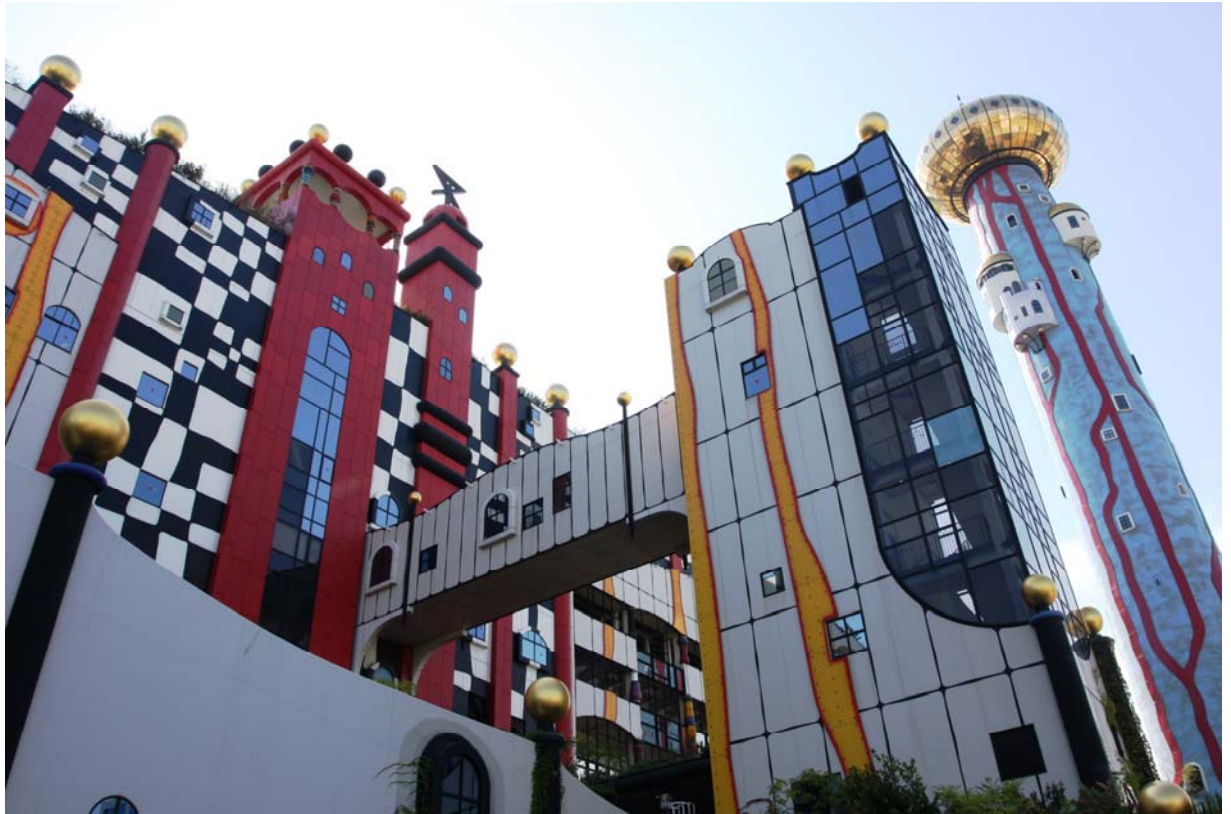
例子二：日本大阪舞州的Maishima Waste-to-Energy Plant，採納了維也納施皮特勞焚化廠為設計藍本。
