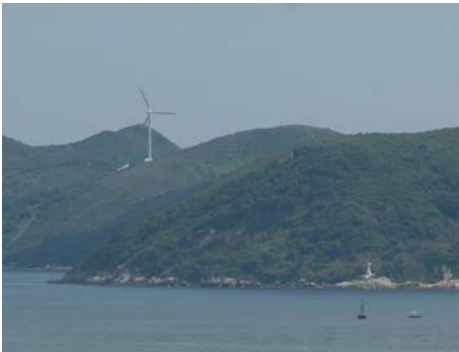
南丫岛上的「南丫风采发电站」为全港首个具商业规模的风力发电站
