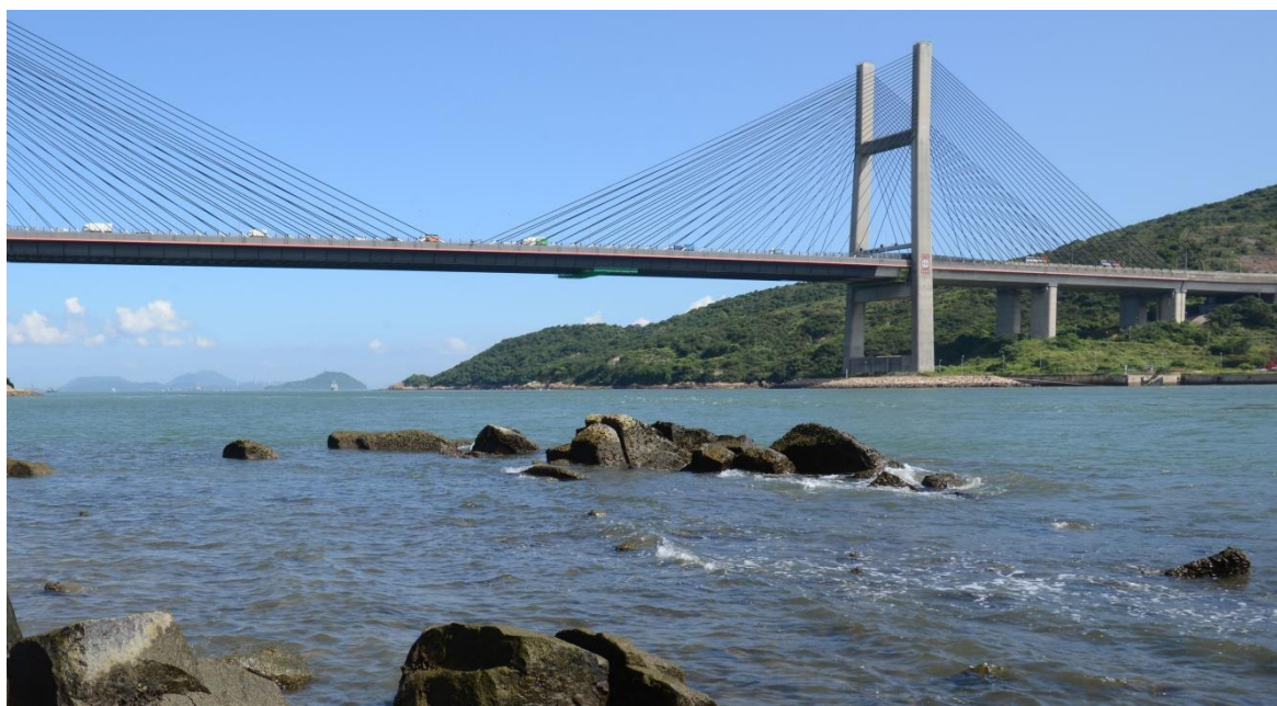
位于西部缓冲区水质管制区内的汲水门大桥
