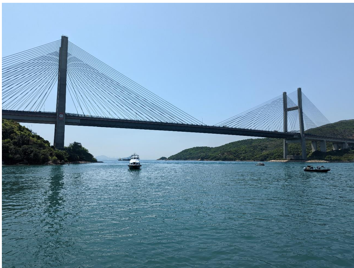
连接马湾及大屿山的汲水门大桥
