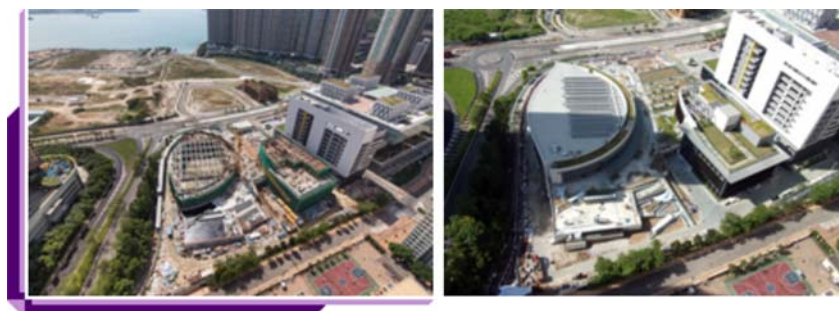
将军澳第74区地区休憩用地、体育馆及图书馆建筑工程（左：施工期；右：项目竣工）
