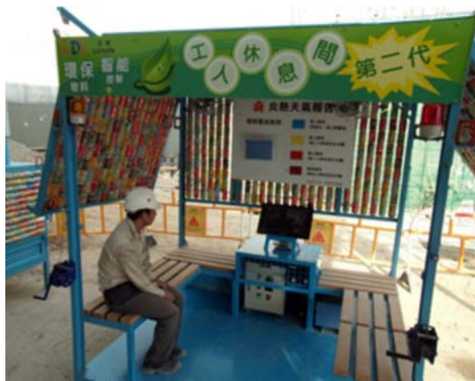
工人休息間裝設自動熱控式可再生能源裝置
