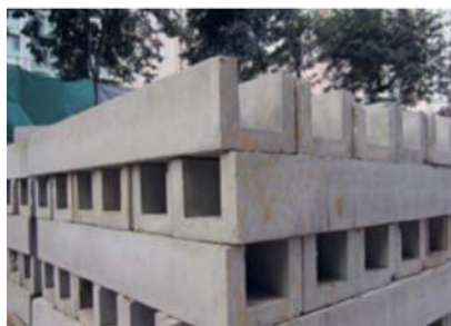
採用預制U形排水渠盡量減省在工地進行模板及混凝土工程
