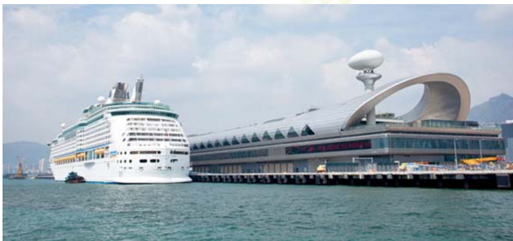
邮轮码头大楼外貌
