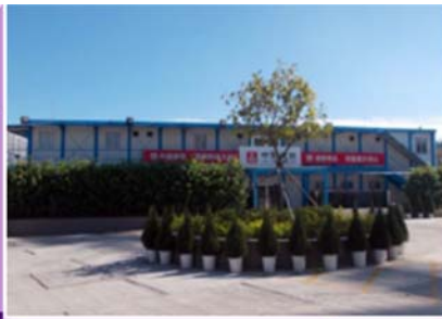
工地绿化及铺砌硬路面
