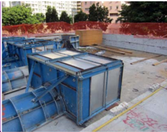
利用特制隔音板阻隔浇筑混凝土柱时发出的嘈杂噪音
