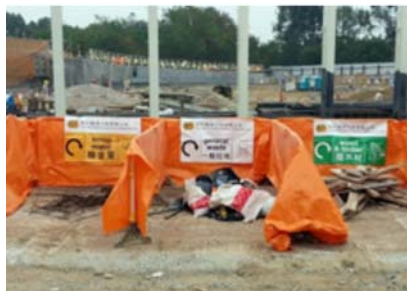
划定工地废物分类专区
