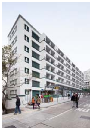
前临士丹顿街的建筑物 外貌
