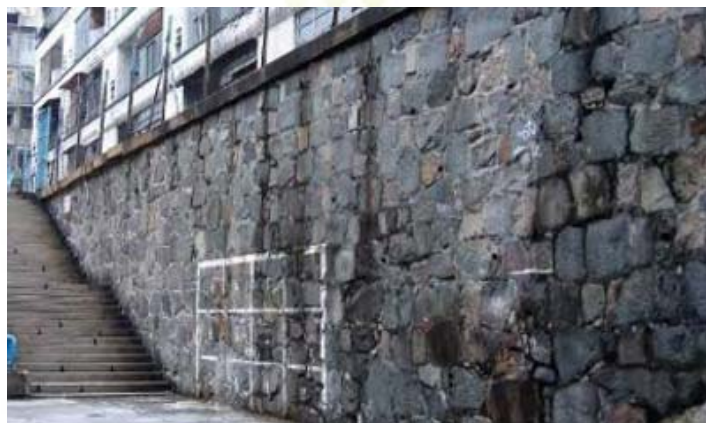
保育通往第4层高台的花岗岩石阶（梯级）和现存的石墙
