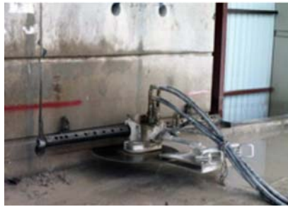
使用低尘量锯切方法进行拆卸工程
