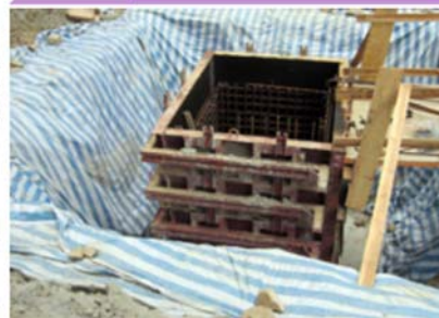
以可再用的鋼模取代木模板
