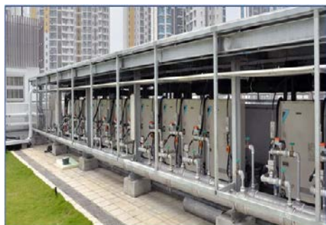
水冷式雙凍量空調系統
