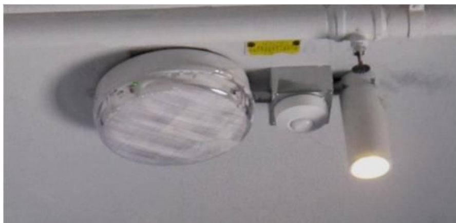
为照明灯安装非接触式感应开关
