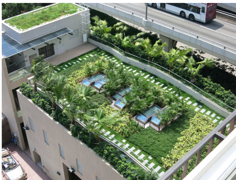
啟德消防局的天台綠化工程 Green Roof at Kai Tak Fire Station
