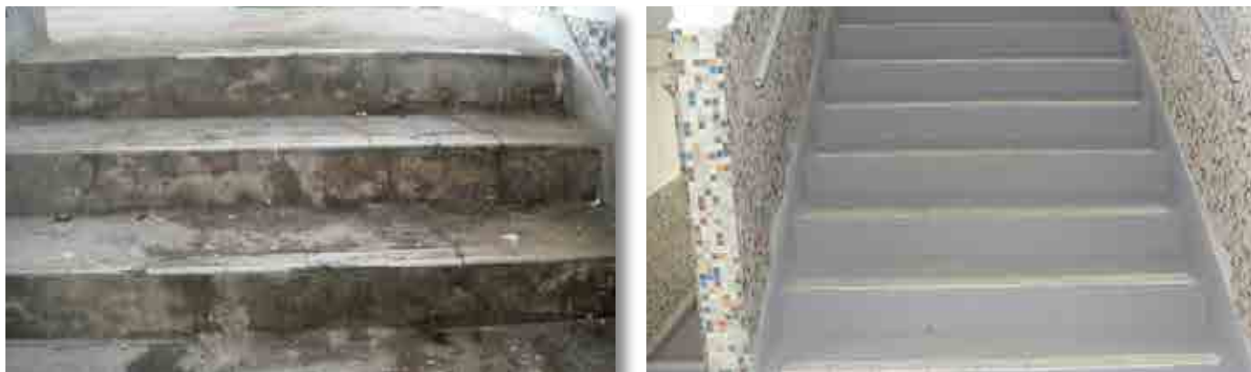
华富(一)邨进行修理及改善工程：施工前(左)及施工后(右)
