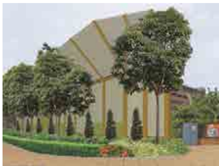
建造隔音屏障在传播路径降低噪音
