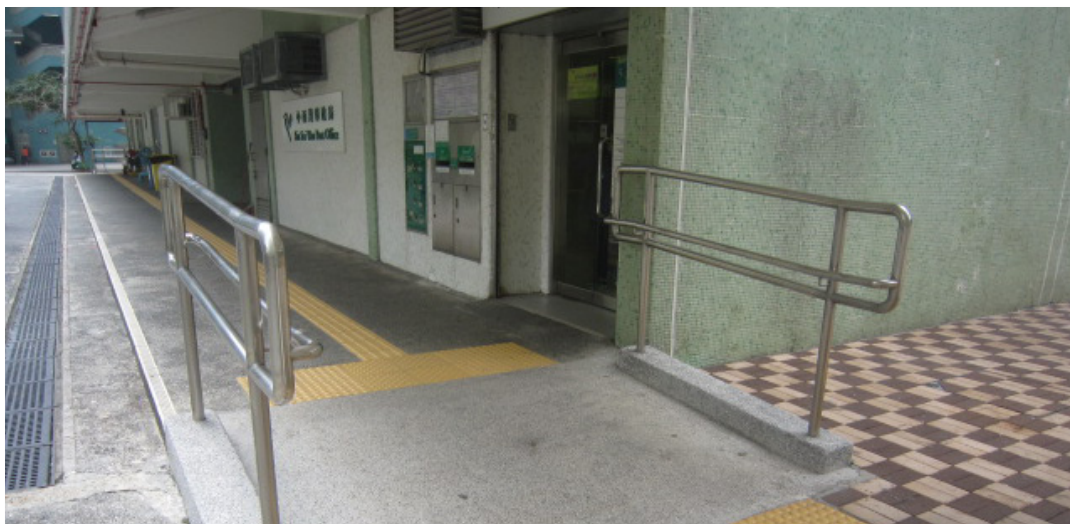
小西湾邨的无障碍通道改善工程
