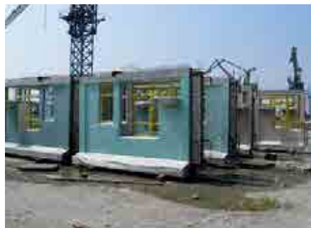
使用预制混凝土组件
