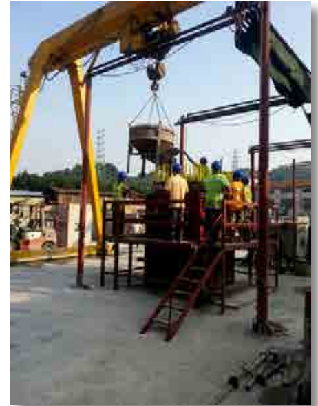
水泉澳一期的预制沙井
