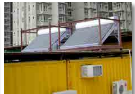
工人淋浴间安装太阳能热水器
