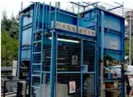
强制安装污水循环处理设施
