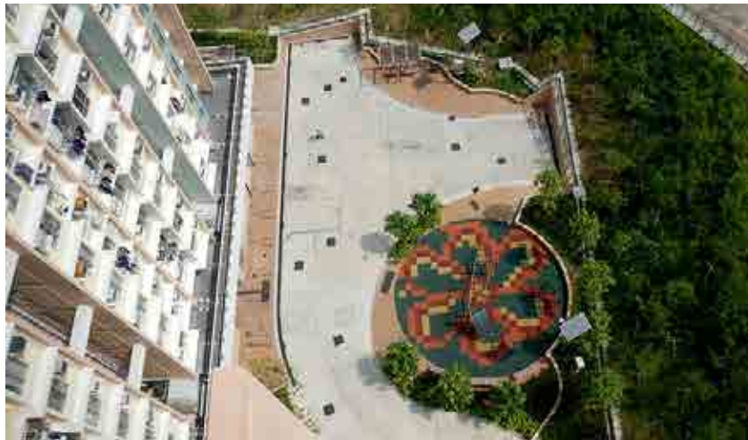
葵涌大白田街新建斜坡的绿化工程
