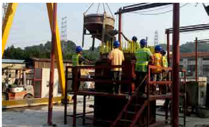
水泉澳一期的预制沙井
