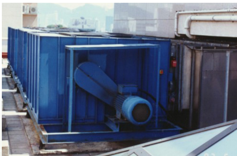
安裝在天台的油煙處理系統
