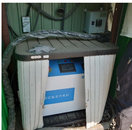
30 千瓦直流 電動輕型貨車 充電器
