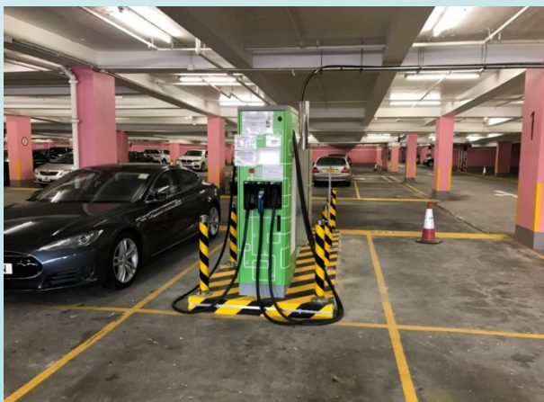
香港國際機場4號停車場
