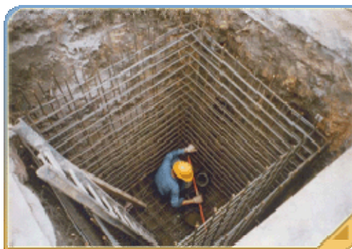
銀線灣的污水系統接駁工程
