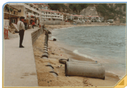
1989年長洲東灣的排水渠改道工程
