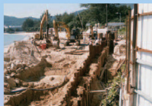
於涌口村進行的渠務建築工程
