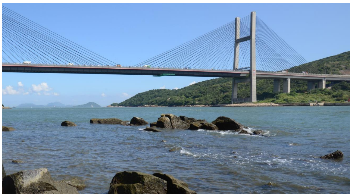
位於西部緩衝區水質管制區內的汲水門大橋
