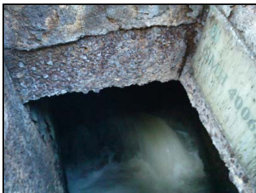
圖片 3 - 污水與雨水收集系統之間的交叉接駁 (位於荃灣芙蓉街)
