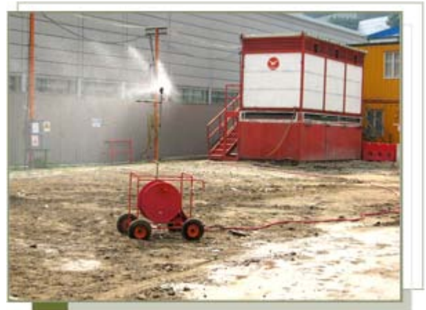
透過流動灑水減低逃逸性塵埃排放
