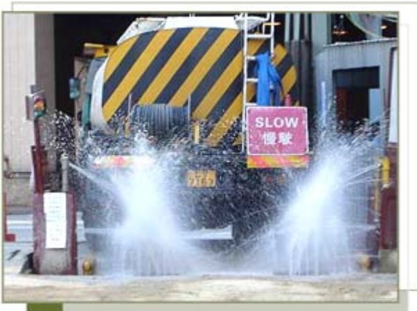
清洗準備離开工地的車輛，避免將污泥帶離工地
