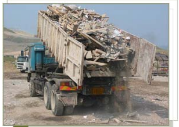
在垃圾傾卸區棄置建築廢料
