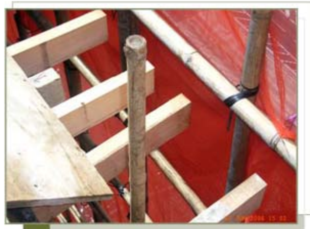
將竹竿尾端削至節點或包裹竹竿末端
