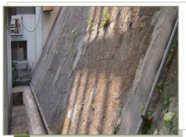
進行例行斜坡維修工作，以防止植物生長和清除明渠的淤塞
