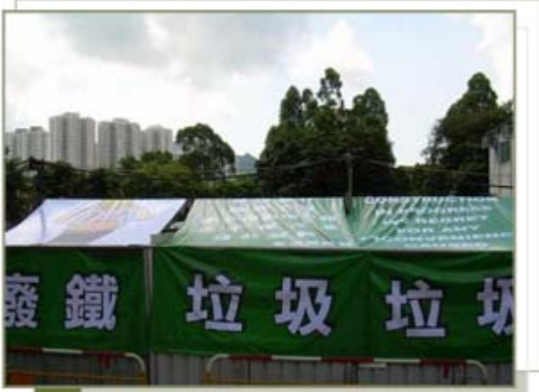
建築廢料在工地分類
