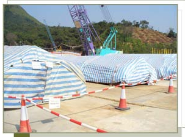
用不滲透布料全面遮蓋材料和定期檢查凹凸不平的表面
