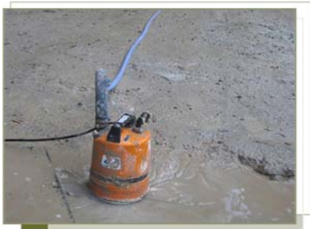
使用輕型水泵來清除地上積水
