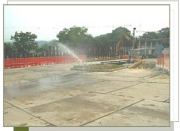
在合適的工地表面以混凝土覆蓋，減少工地車輛行駛時的揚塵
