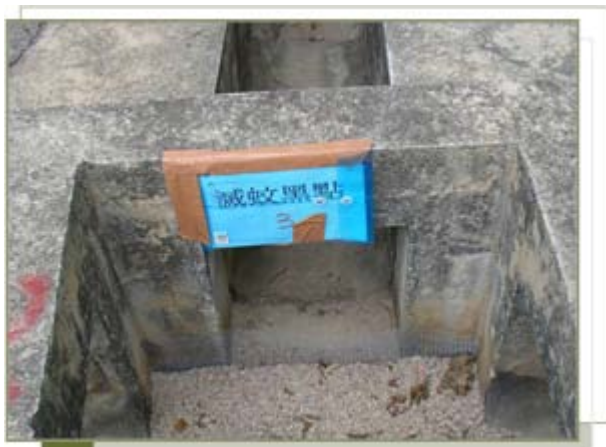
用顆粒物料填補集水井，避免積水及消除蚊子滋生黑點
