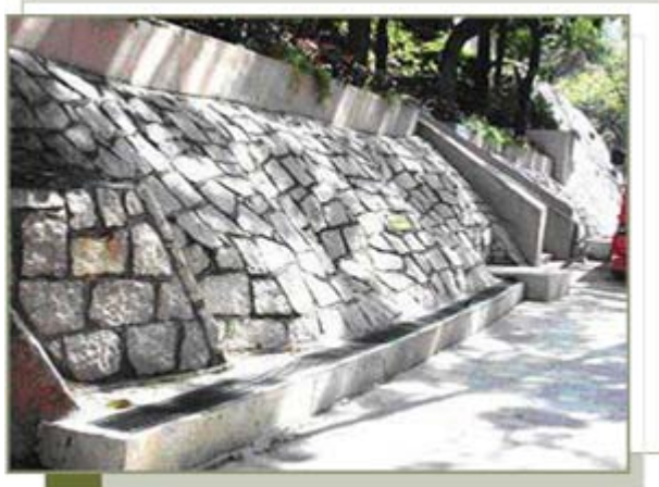
進行斜坡改善工程，加快水源從斜坡流出的速度
