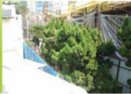
樹木鋪上膠膜防止棚架及建造工程造成損害 6
