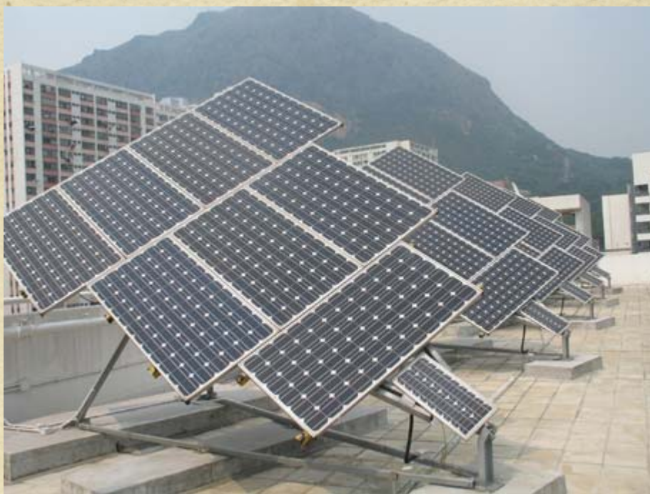
裝有太陽追蹤器的太陽能光伏板
