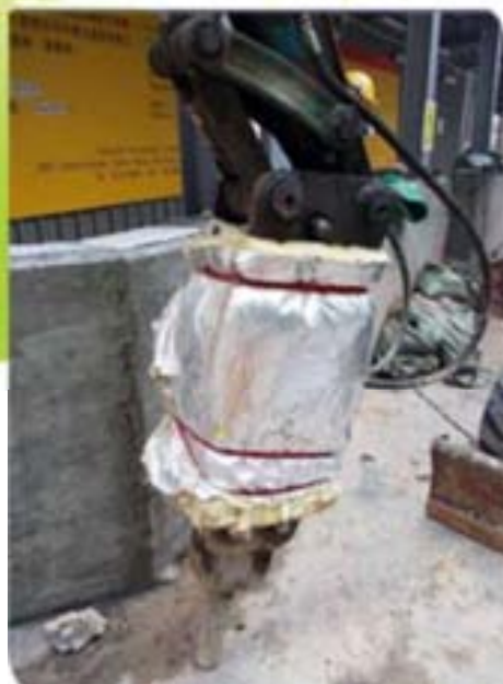
破碎機隔聲套 3
