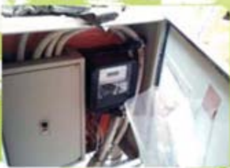
裝設電錶監察工地耗電量 6
