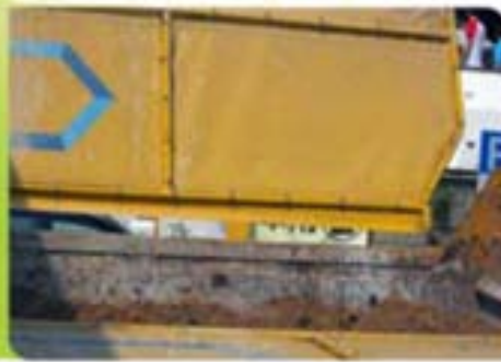
運載廢物貨車裝設機械蓋 6
