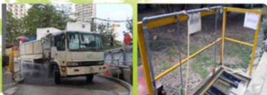
工地出口的輪胎沖洗設施 3
