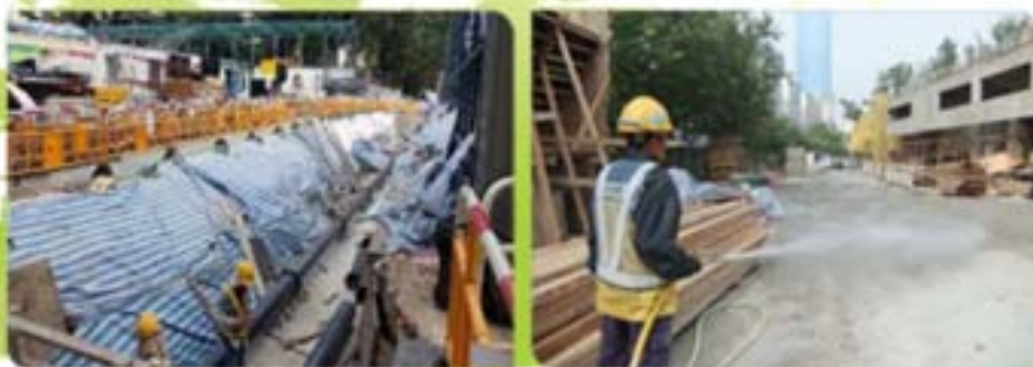
鋪蓋正進行挖土工程的表面 3
