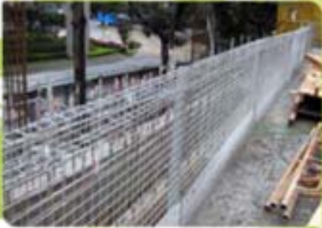
重複使用以往工程項目的金屬圍欄 4
