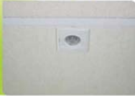
控制寫字樓電燈的移動感應器 4
