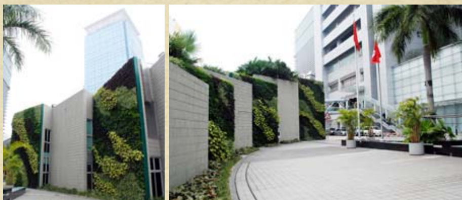
機電工程署總部的垂直綠化牆
