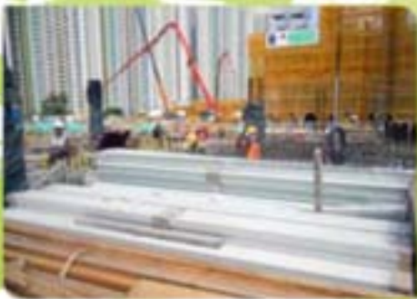
玻璃纖維模板取代木模板 5
