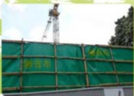
建築工地四周設置隔音屏 2
