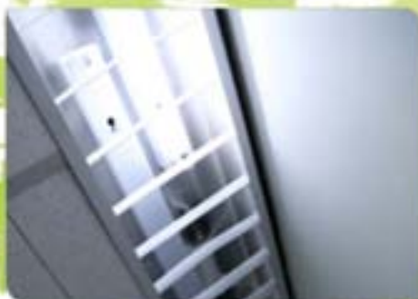
改裝照明系統，減少使用光管
