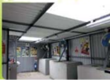
安裝透明天窗利用天然採光節約照明能源 4
