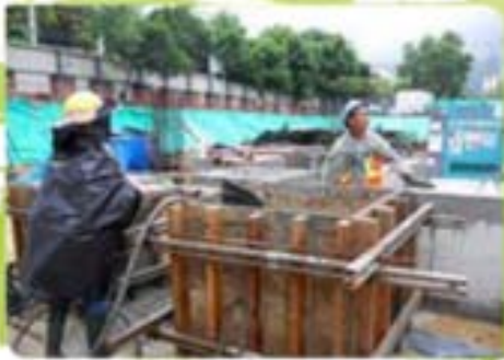
利用剩餘混凝土製作建築組件 5
