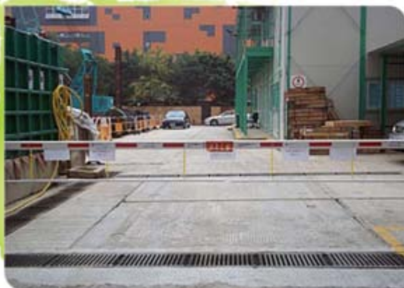
在建築工地採用預制混凝土板作臨時鋪路
