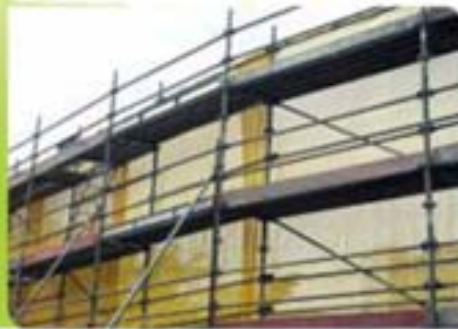
以金屬棚架取代竹棚架 6
