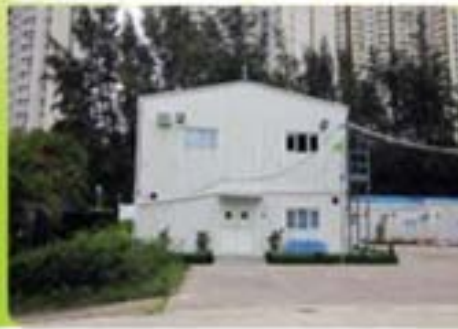
工地寫字樓周圍栽種植物 4
