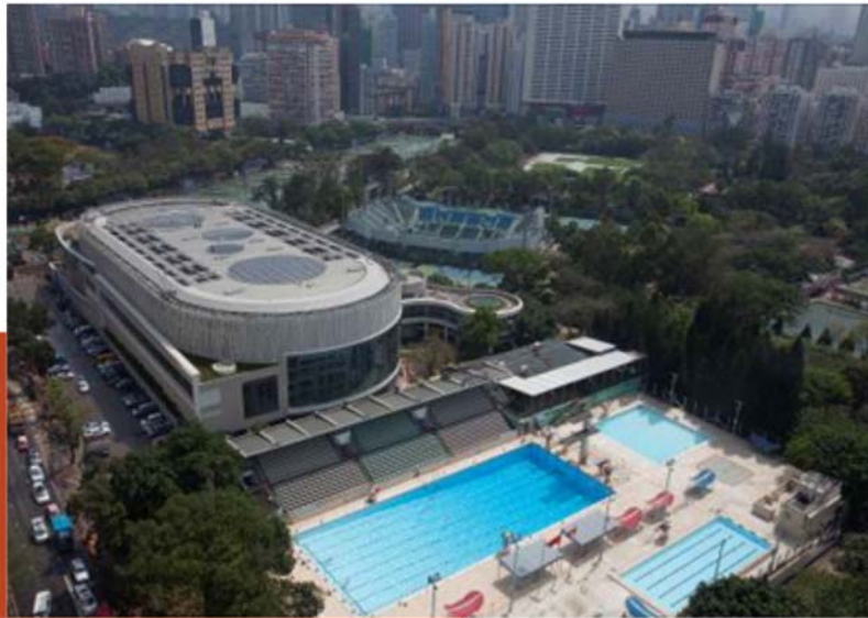
維多利亞公園游泳池重建項目
