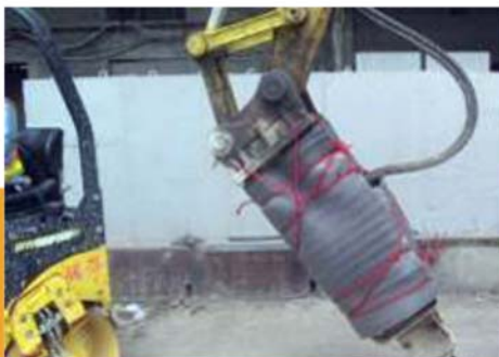
油壓破碎機裝上吸音套
