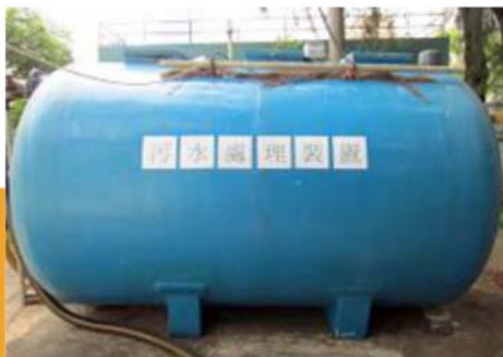
污水處理系統
