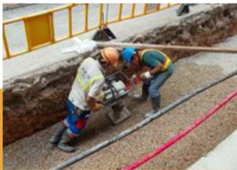
壓實外露土層表面
