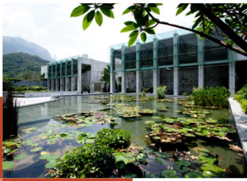
鑽石山火葬場重置工程項目
