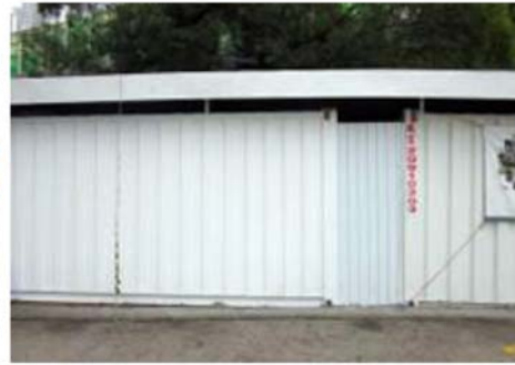
辦公室裝設金屬天台及氣隙改善通風
