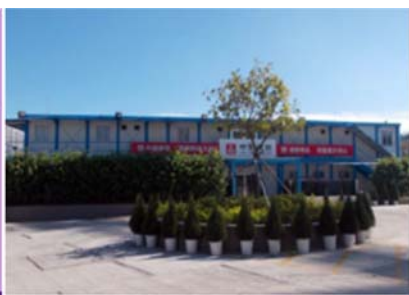
工地綠化及鋪砌硬路面
