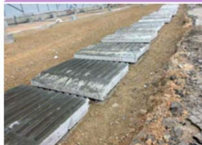
耐用材料回收再用作鋪路磚
