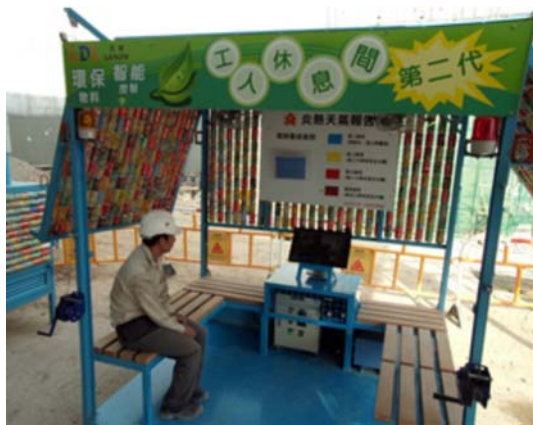
工人休息間裝設自動熱控式可再生能源裝置
