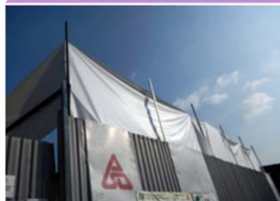
架設隔塵板
