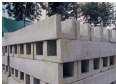
採用預製U形排水渠盡量減省在工地進行模板及混凝土工程
