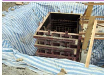
以可再用的鋼模取代木模板
