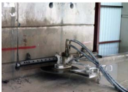
使用低塵量鋸切方法進行拆卸工程
