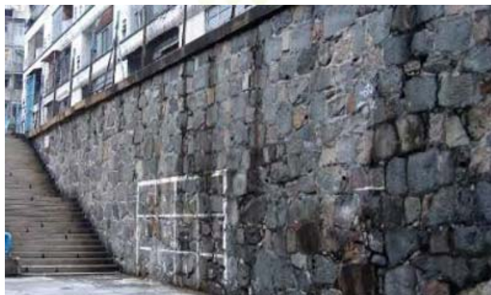
保育通往第4層高台的花崗岩石階（梯級）和現存的石牆
