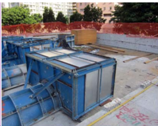
利用特製隔音板阻隔澆置混凝土柱時發出的嘈吵噪音
